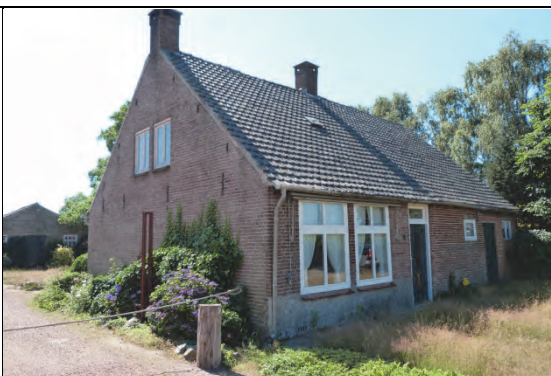
Voorzijde woning op westelijke deel van erf
