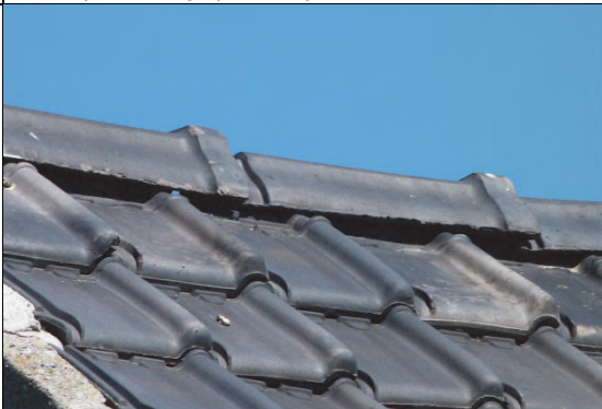
Ruimte onder nokpannen van woning
