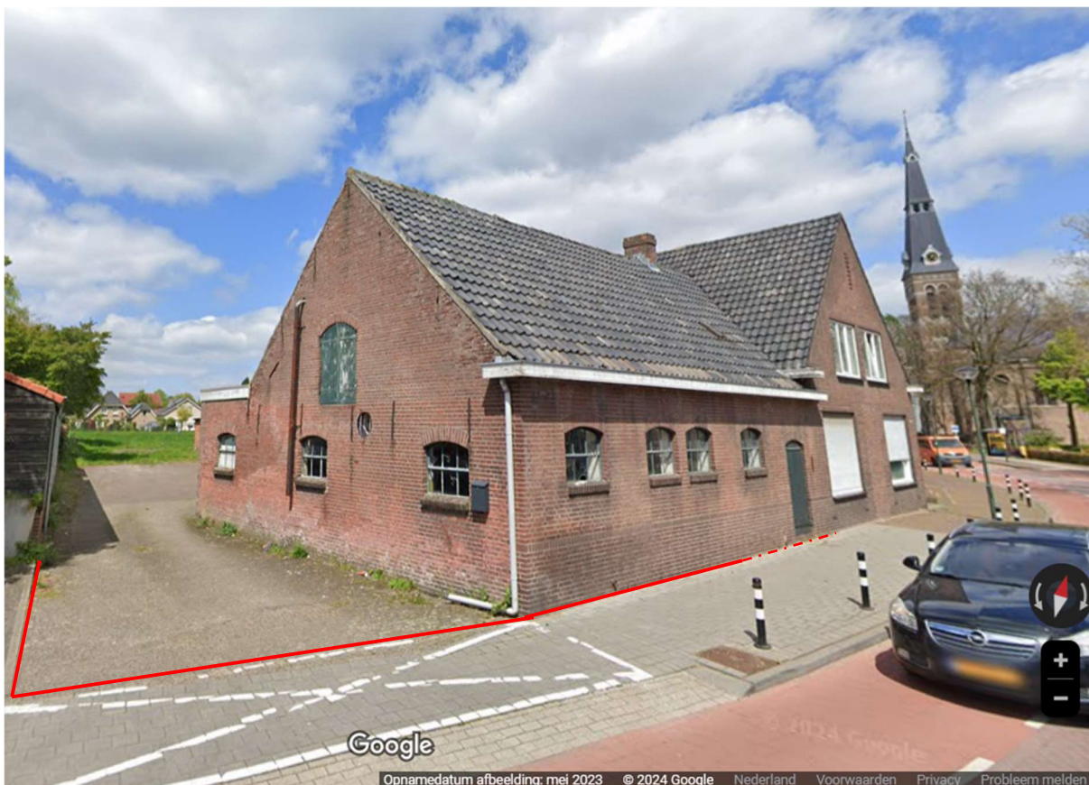
Figuur 5.1 Zuidoosthoek van het plangebied (rode lijnen) met het pand van Kerkstraat 26. Het zuidelijk deel van het pand dat samenvalt met het plangebied, zal worden gesloopt. Het herbergt in de bodem mogelijk funderingsresten van het originele bouwwerk uit 1811-1832 of van een oudere voorganger (bron: Google Maps).
