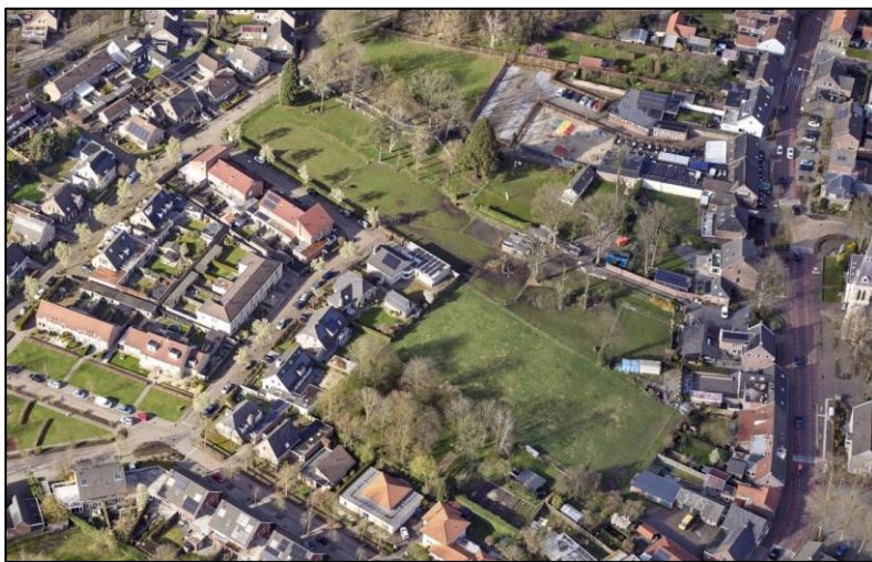
Luchtfoto plangebied (bron: Slagboom en Peeters)
