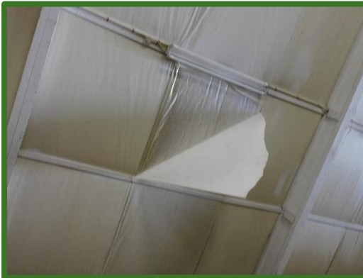
Dakisolatie noordelijke deel
