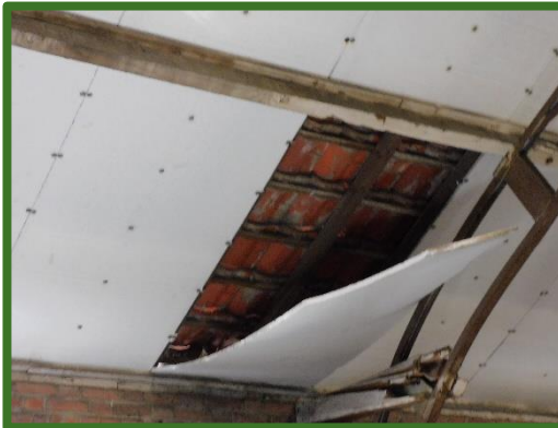
Dakisolatie zuidelijke deel
