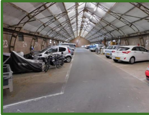
Zuidelijke gedeelte van de loods
