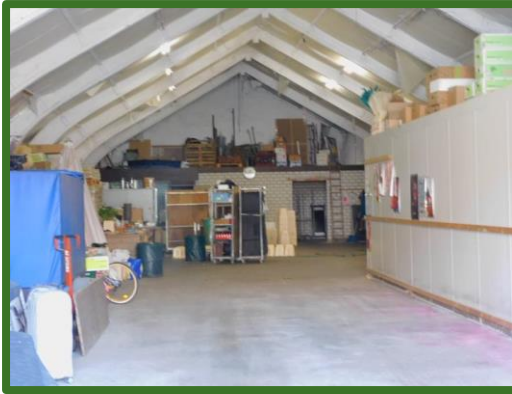
Binnenzijde noordelijke gedeelte van de loods
