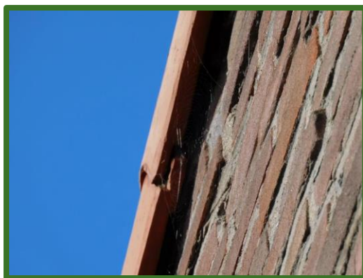
Ruimte onder de dakpannen
