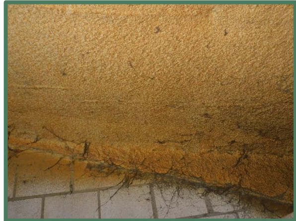
Onderkant dak met pur
