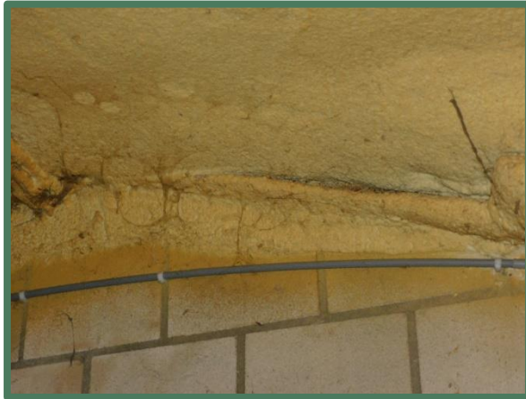
Onderkant dak met pur
