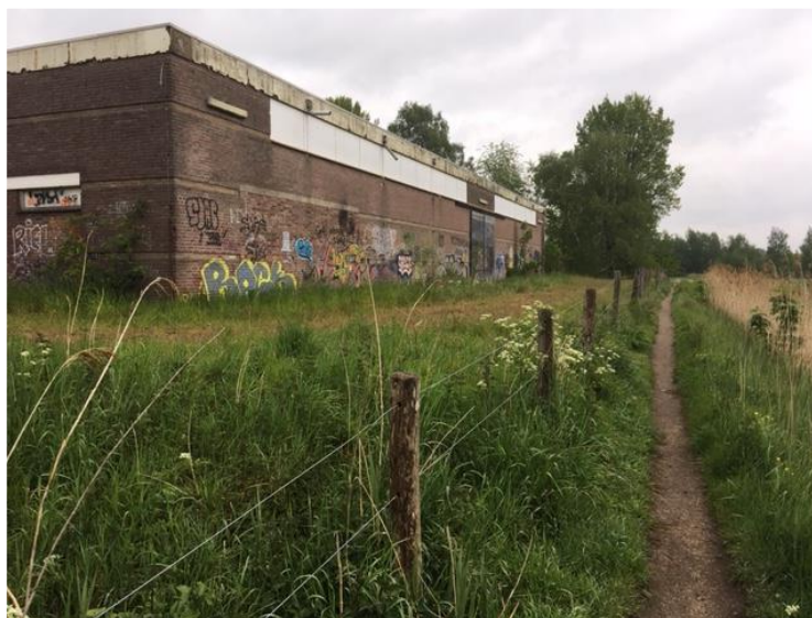
Figuur 3. Bestaande bebouwing
