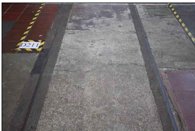
Afbeelding 3.22 In enkele gebouwen zijn nog rails aanwezig voor het scheren van kettingbomen. 70 (foto: A. Oldenmenger).
