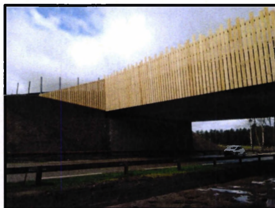
Recent aangelegde faunapassage
