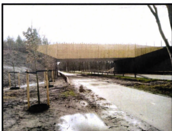
Recent aangelegde faunapassage
