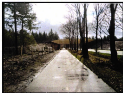
Recent aangelegde faunapassage
