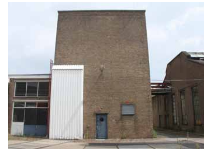
16. Gevelaanzicht van het accu- en pompgebouw.
