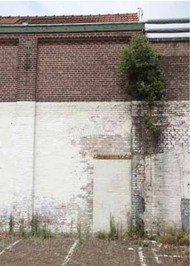
7. Gevelaanzicht van de weverij.
