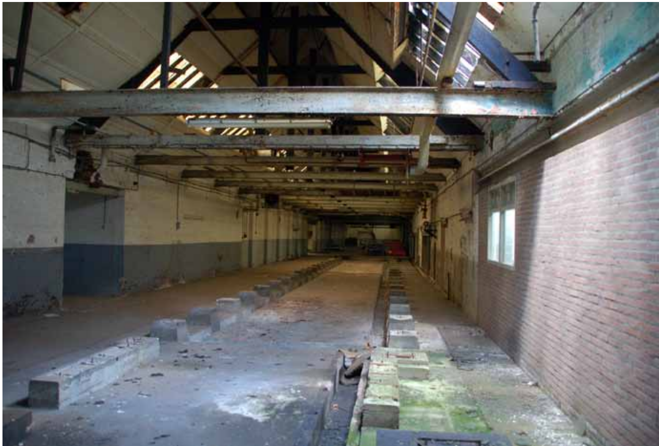
I. Spantconstructie in goede staat.
