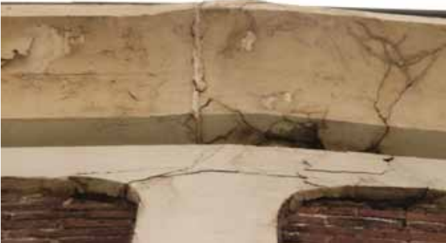
3. Deze foto is genomen op de plaats waar de gevellijn knikt, overgang gebouw 2 op 3.
