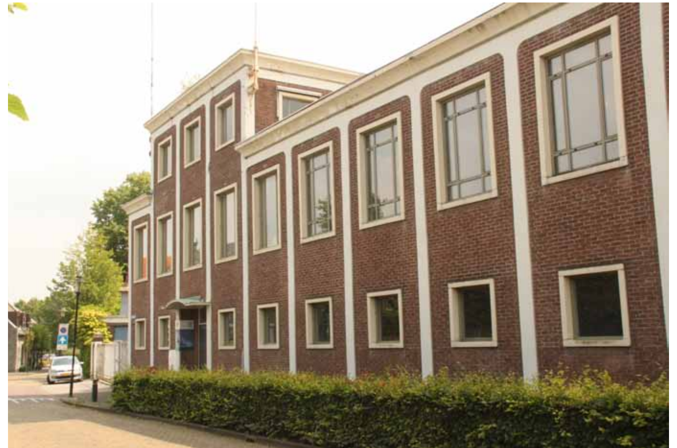
2. Gevel langs de Kerkstraat.
