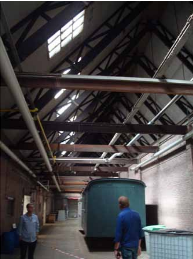
XVIII. Kapconstructie met bijzondere vakwerkspanten is in goede staat.
