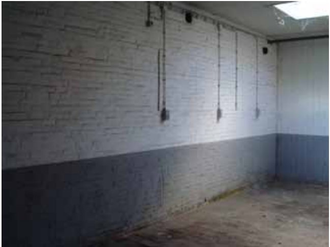
XVII. Staat van het metselwerk is goed.
