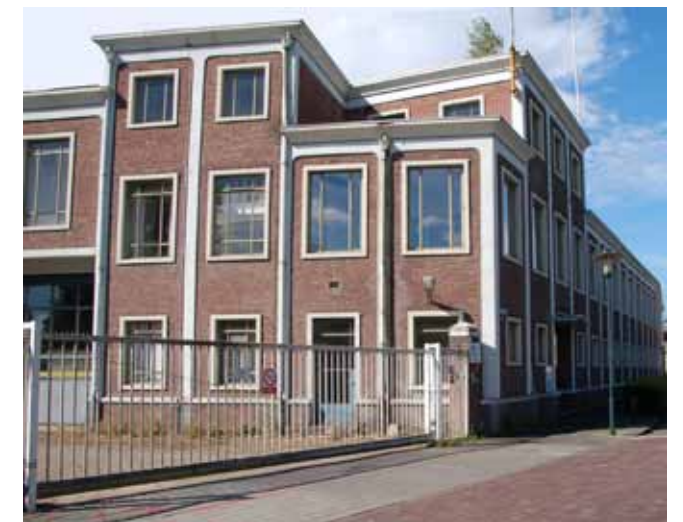
Hoek van het kantoor Van Besouw aan de Kerkstraat.
