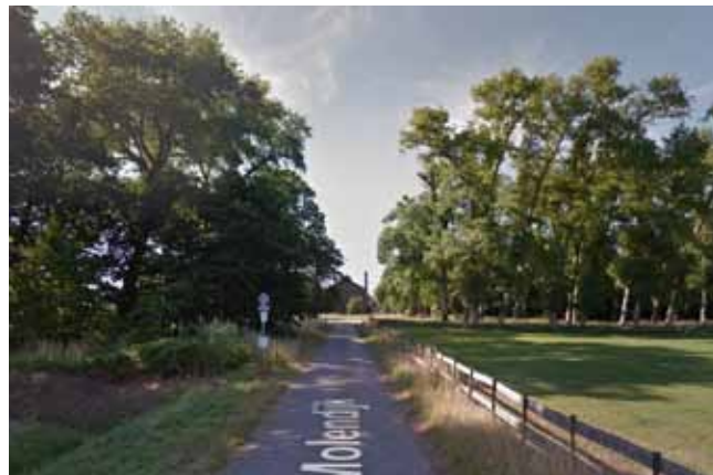
Foto vanaf de Molendijk met zicht op de gebouwen en schoorsteen van Van Puijenbroek. - Bron: Google maps
