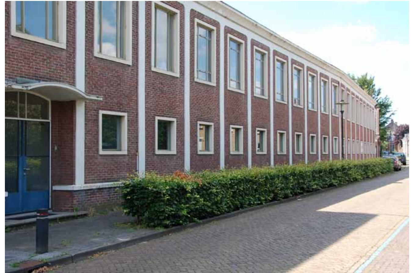
Gevel van het hoofdkantoor Van Besouw aan de Kerkstraat. De gevel buigt mee met de knik van de straat.
