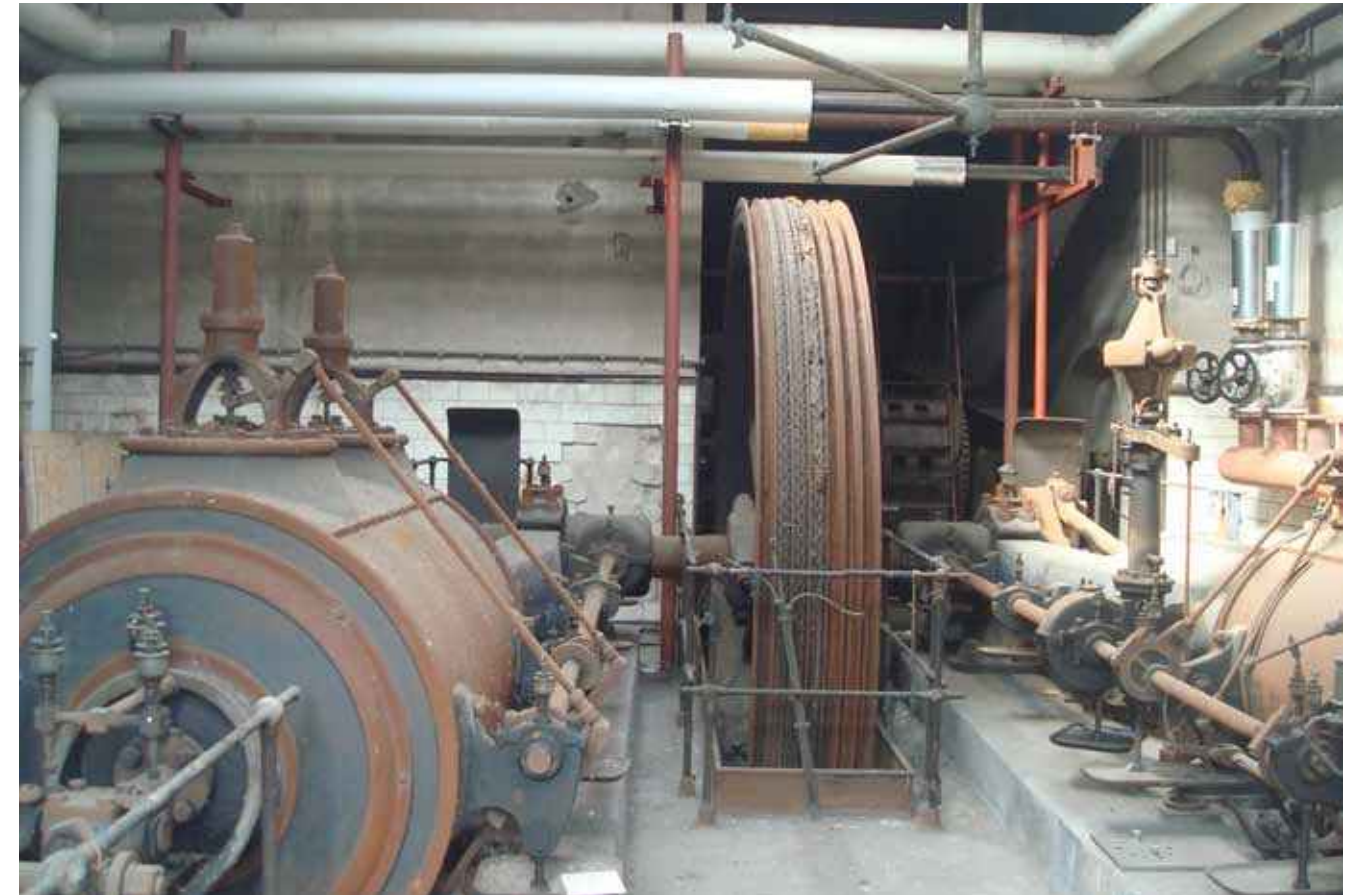
V. Interieur Machinekamer.
