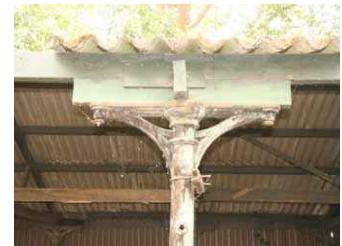
13. Detail gietijzeren kolom
