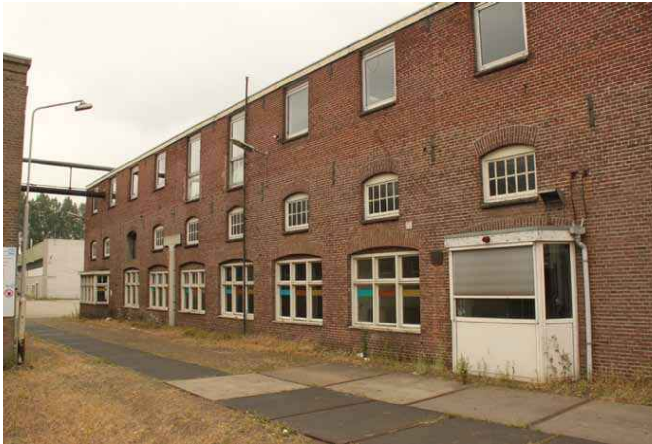
8. Gevelaanzicht van het magazijn.
