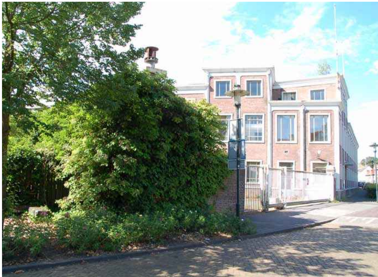
Hier is goed de poort zichtbaar tussen het transformatorhuisje en het hoofdkantoor. De achterzijde van het transformatorhuisje is geheel bekleed met beplanting.
