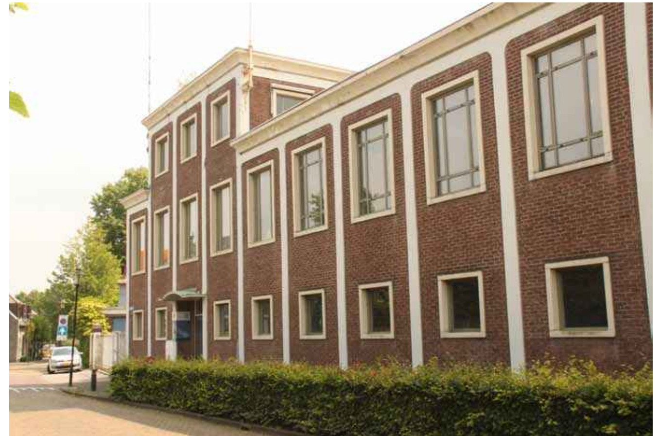
2. Gevel langs de Kerkstraat.
