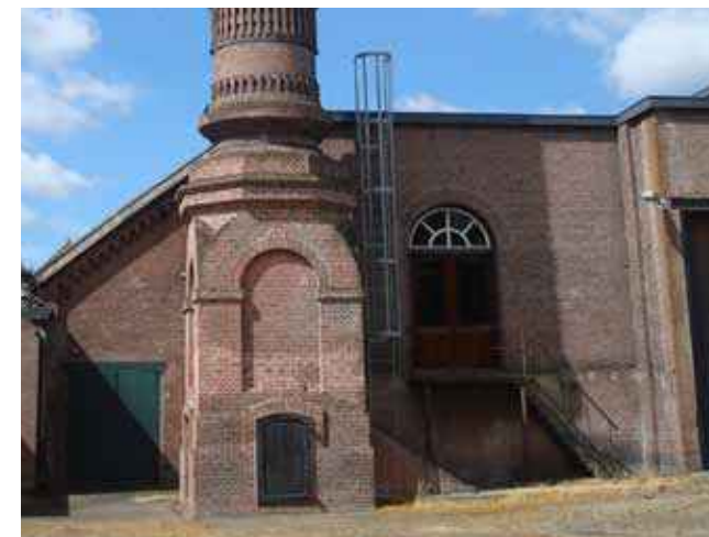
V. Gevel machinekamer.
