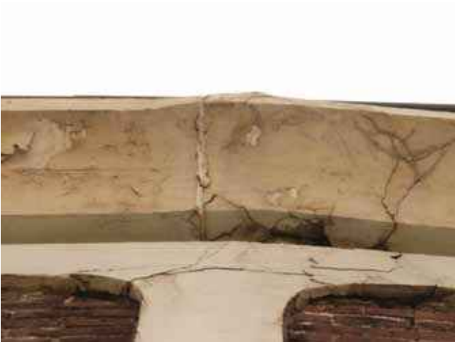
3. Deze foto is genomen op de plaats waar de gevellijn knikt, overgang gebouw 2 op 3.
