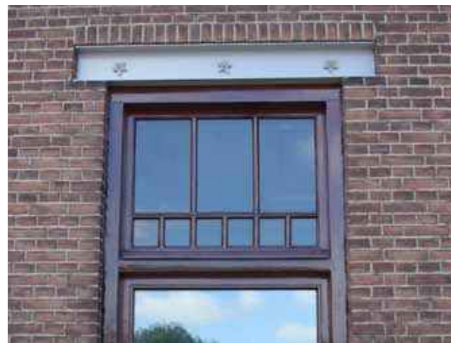
Zorgvuldig ontworpen kozijnen met lateien in het hoofdkantoor van Van Puijenbroek.
