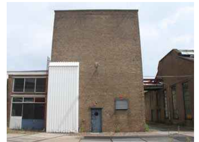
16. Gevelaanzicht van het accu- en pompgebouw.
