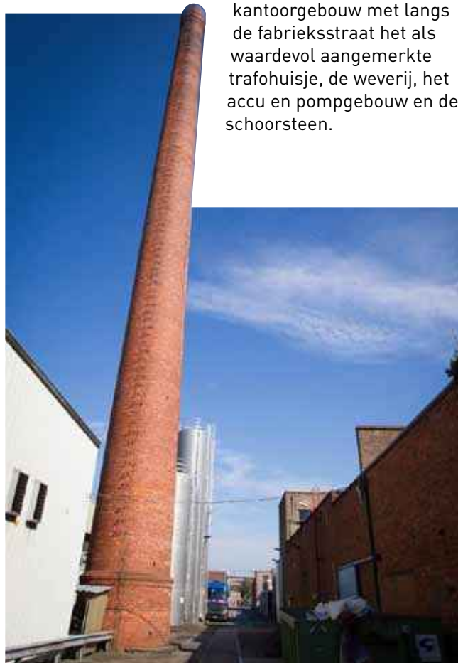
Schoorsteen Van Besouw. - bron: BAAC Bouwhistorische verkenning locatie Van Besouw
