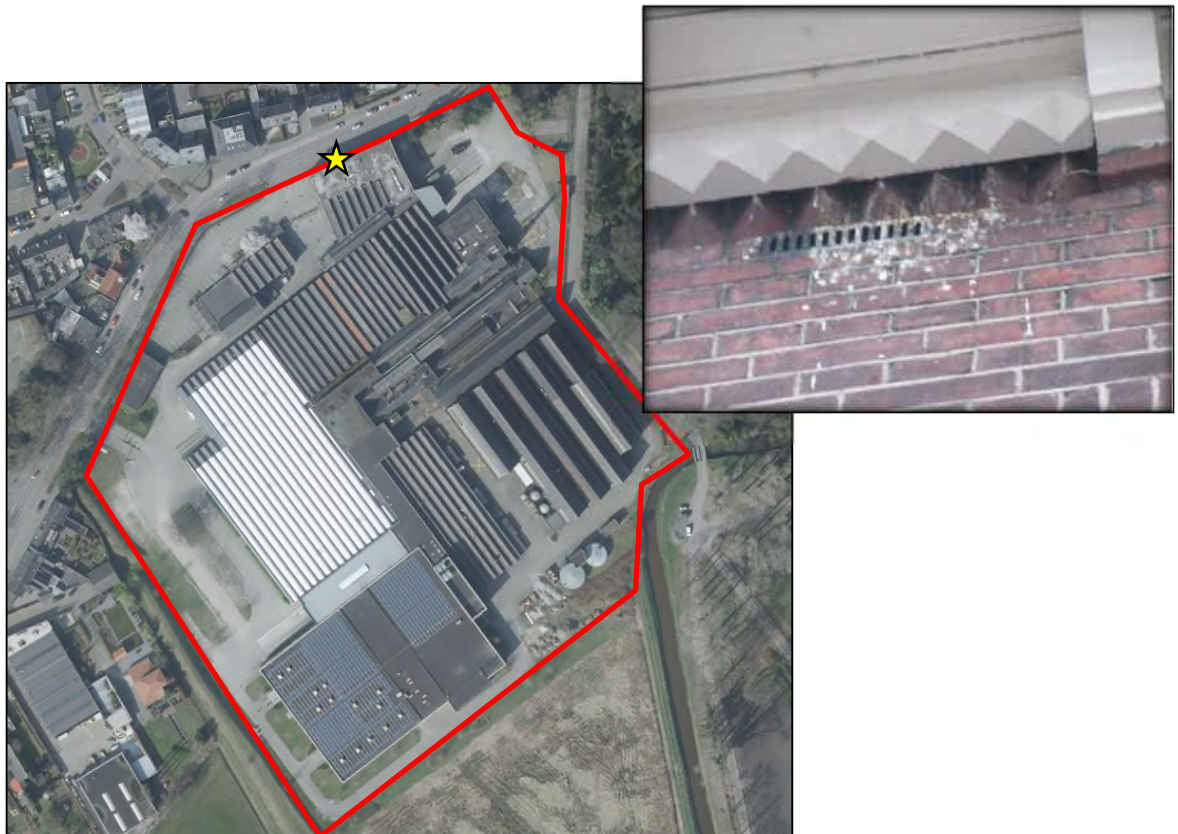
Figuur 5.1: Locatie binnen het plangebied waar één nestplaats van de gierzwaluw is aangetroffen (ster; Bron ondergrond: Globespotter).
