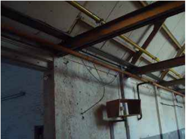
XVI. Spanten opgelegd in penanten, opleggingen zijn in goede staat.
