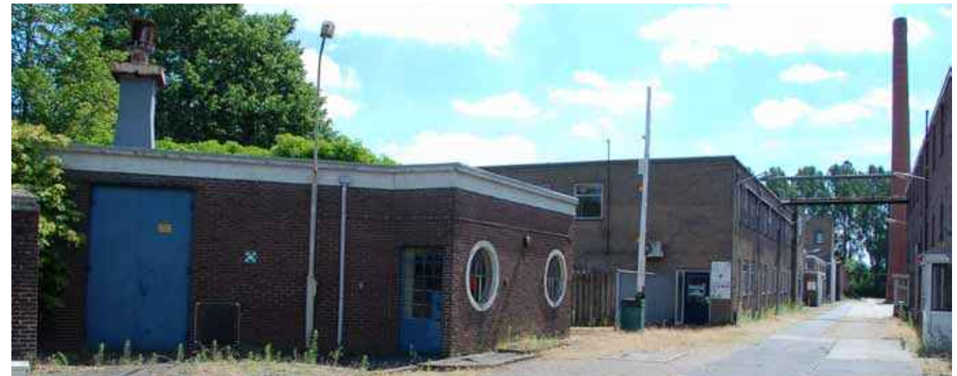
Het transformatorhuisje met kenmerkende ronde ramen.
