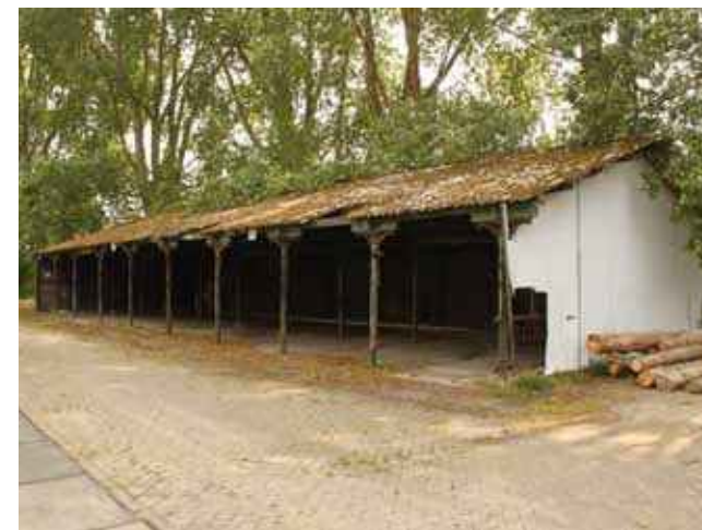
13. Bergloods achter op het terrein.
