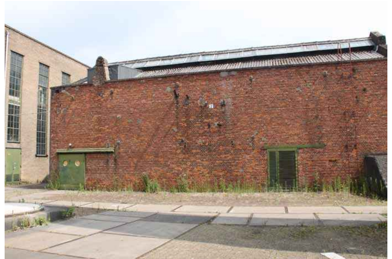
15. Gevelaanzicht van het Ketelhuis met links de zijgevel van het accu- en pompgebouw.
