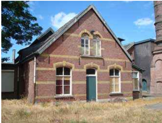
I. Voorgevel in redelijke staat.
