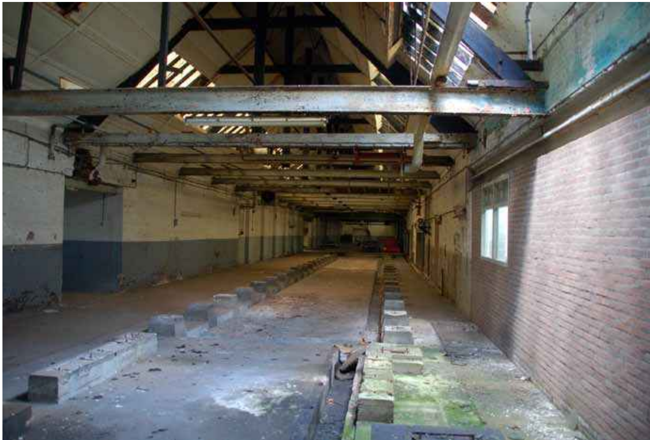
I. Spantconstructie in goede staat.
