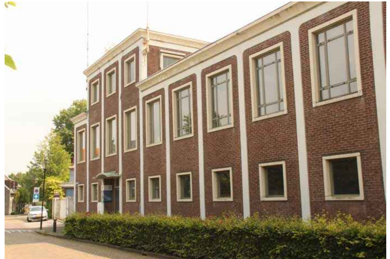
2. Gevel langs de Kerkstraat.
