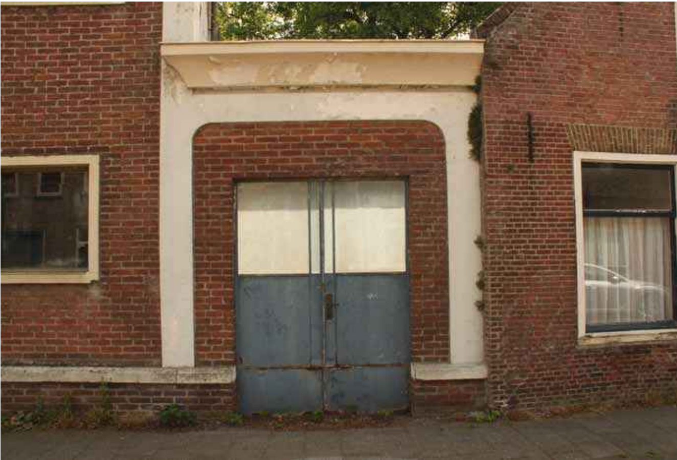
4. Gevelaanzicht van het magazijn dat als tussenlid naast het hoofdkantoor fungeert.
