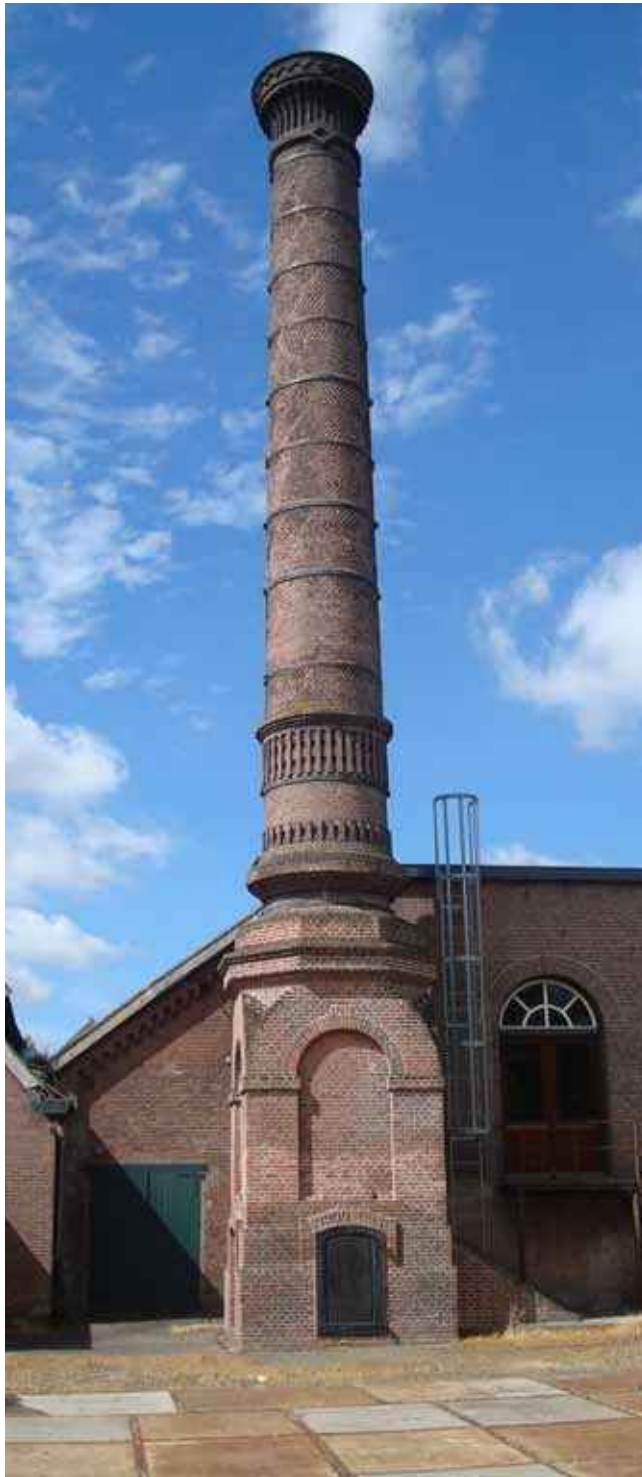
III. Aanzicht schoorsteen.
