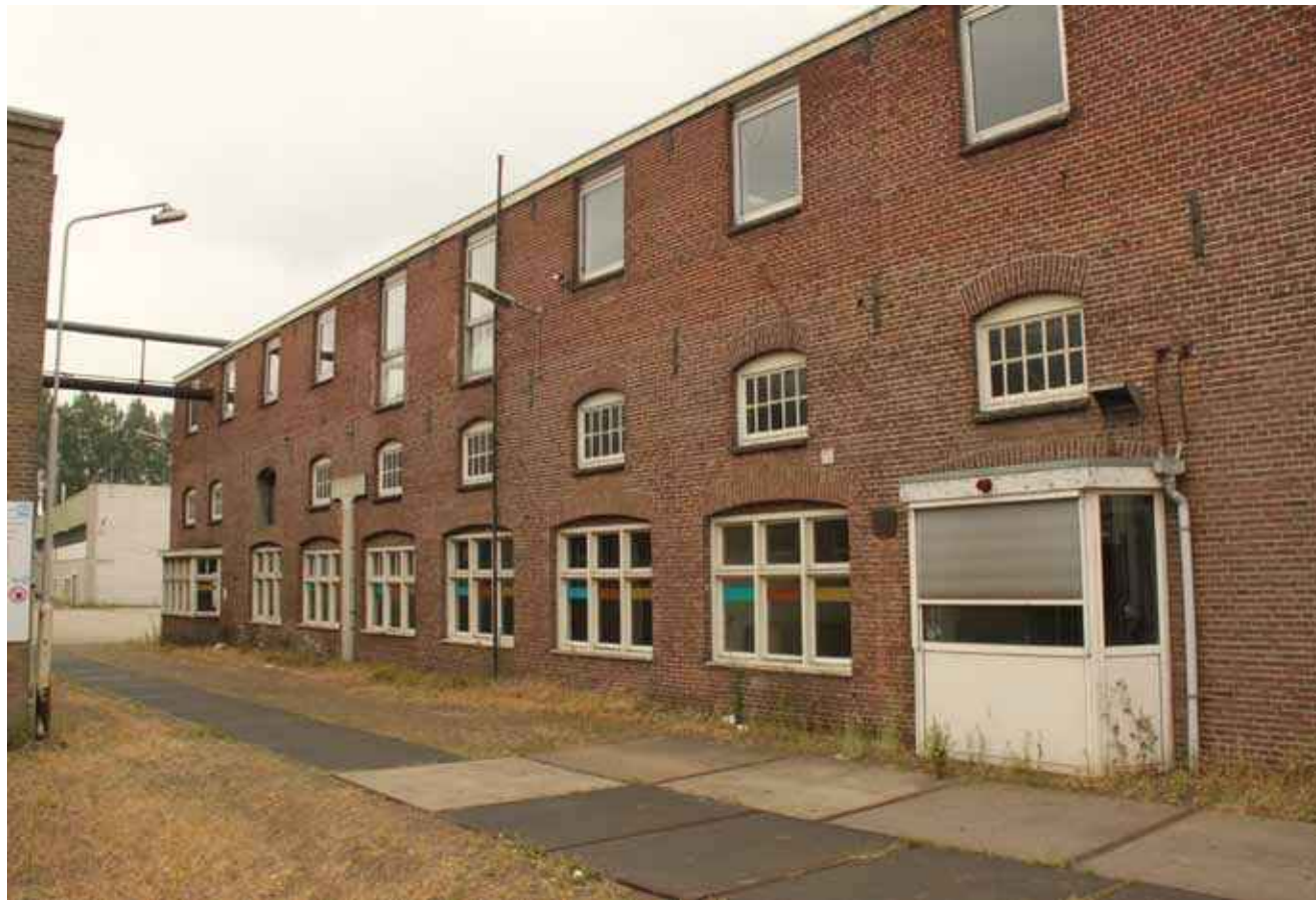
8. Gevelaanzicht van het magazijn.
