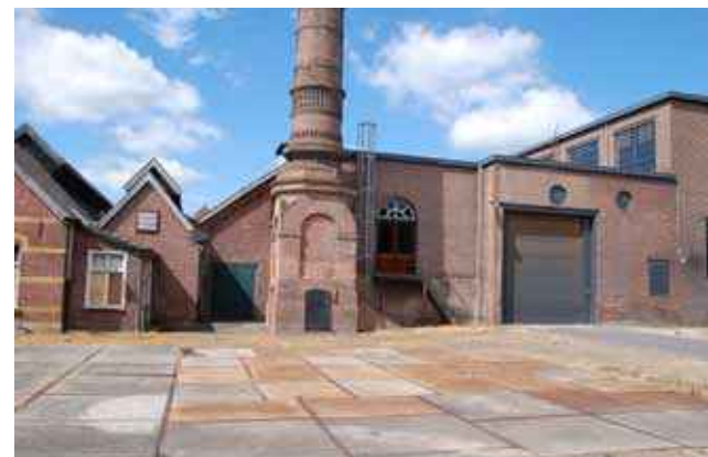
Fabrieksplein van Van Puijenbroek. Een collage van hoogtes, daken, steenkleur en details.
