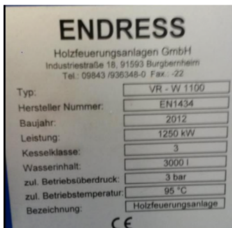
Figuur 2.3 Typeplaatje van de biomassacentrale
