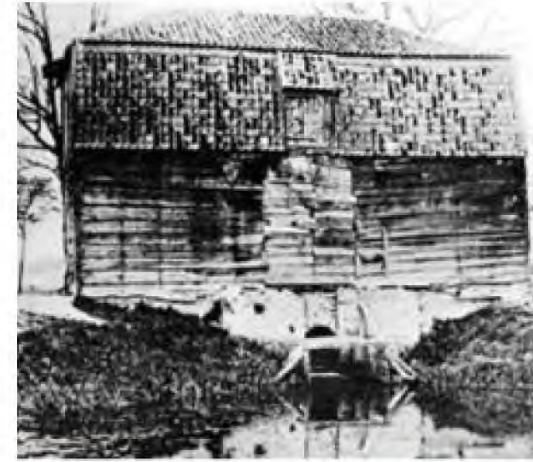
Onderslag watermolen Goirle (oorspronkelijk korenmolen en oliepersmolen, later korenmolen en schorsmolen (basis voor de leerlooierijen en voor vulling kaatsballen))
