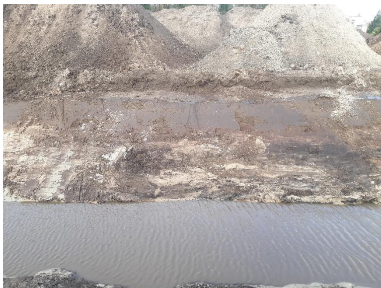
Afbeelding 7. Impressie van de bodemopbouw ter plaatse van werkput 2.3 (de nieuwe geul/beek) (Foto: Antea Group).
