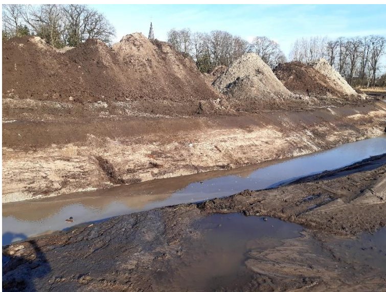
Afbeelding 5. Impressie van de bodemopbouw ter plaatse van werkput 2.2 (de nieuwe geul/beek) (Foto: Antea Group).
