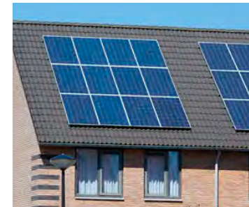
zonnepanelen geïntegreerd in dakvlak
