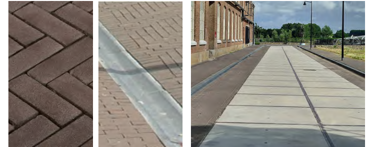
gebakken klinkers en betonnen platen
