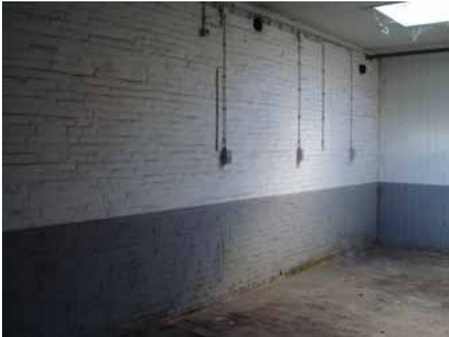
XVII. Staat van het metselwerk is goed.
