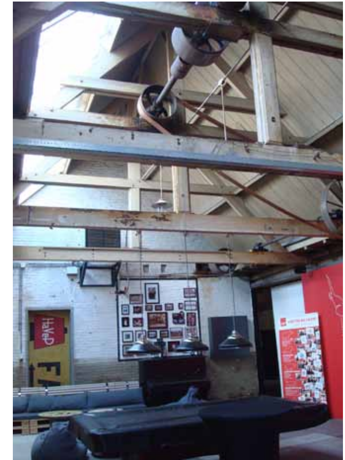
VII. Metsel en houtwerk zijn in goede staat.
