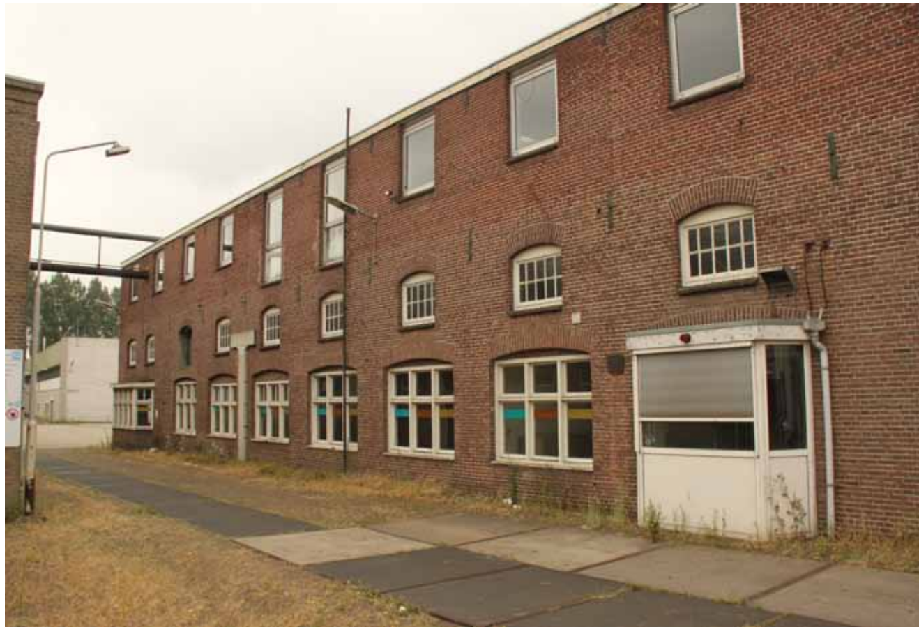
8. Gevelaanzicht van het magazijn.
