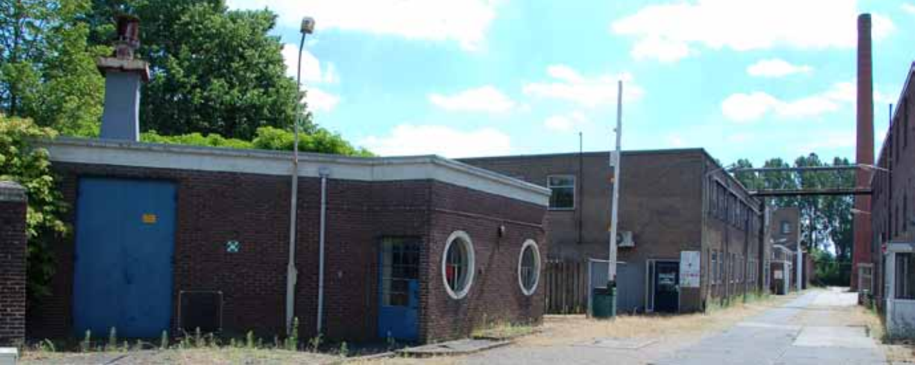
Het transformatorhuisje met kenmerkende ronde ramen.
