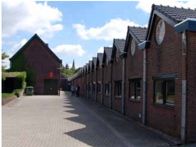
De sheddaken met rosetramen en opvallend ritme van daken, goten en hemelwaterafvoeren.
