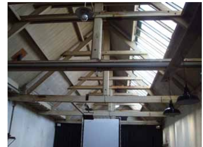
VII. Kapconstructie met links de zakgoot over de trekbalen.
