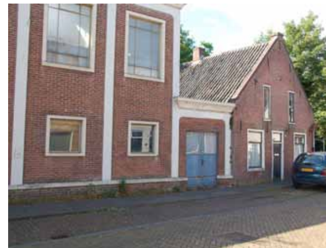
Zorgvuldig ontworpen overgang tussen fabriekshuisje en de gevel van het hoofdkantoor.
