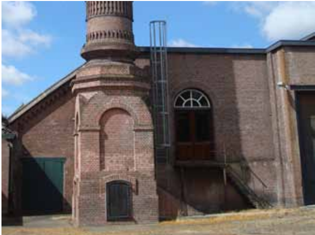
V. Gevel machinekamer.
