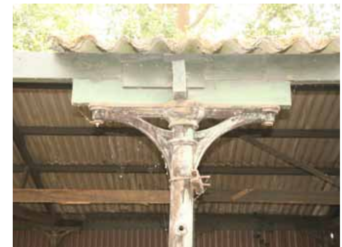
13. Detail gietijzeren kolom
