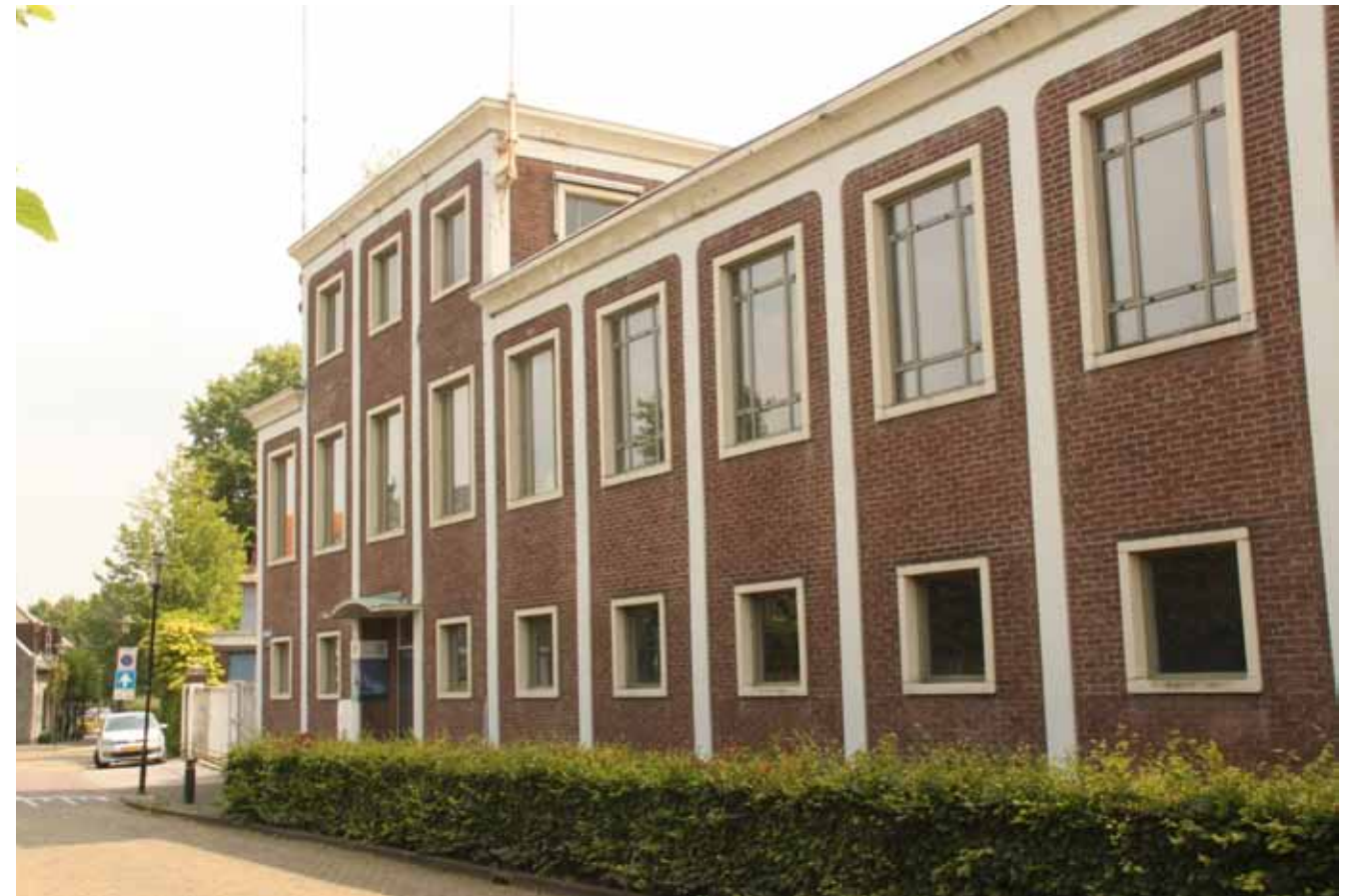
2. Gevel langs de Kerkstraat.
