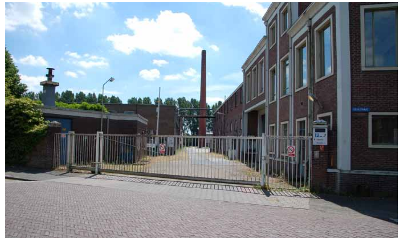
De poort bij Van Besouw tussen transformatorhuisje en hoofdkantoor. Vanuit de poort leidt de fabrieksstraat tot aan de schoorsteen.
