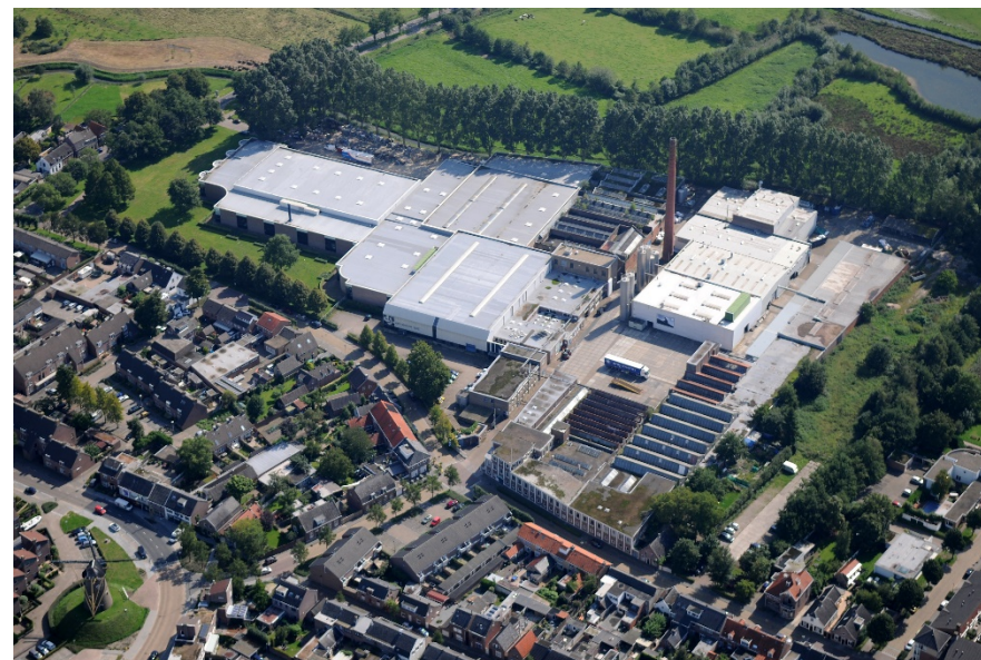
Luchtfoto locatie Van Besouw september 2015 ^
