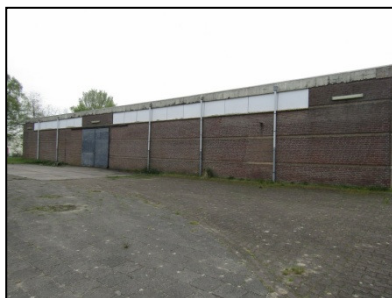
Figuur 3. Westzijde van de loods.
