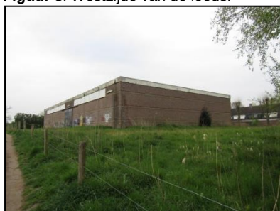
Figuur 6. Noord- en oostzijde onderzoekslocatie.
