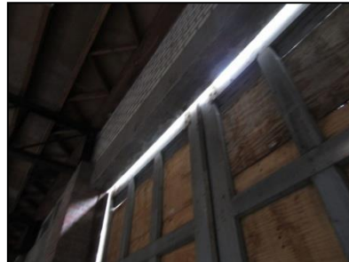
Figuur 10. Kieren bij schuifdeuren geven toegang tot de loods.
