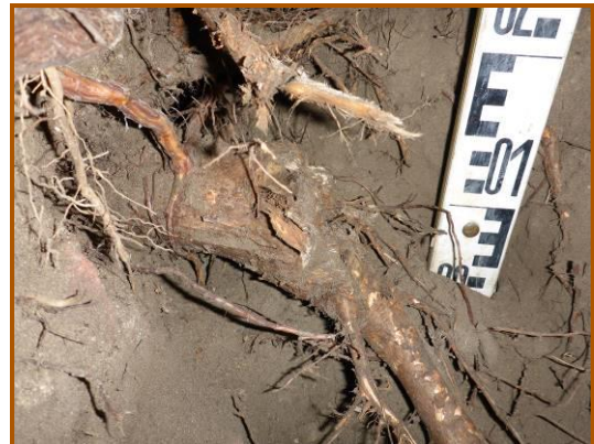
Afbeelding 7: Grote wortel Ø 8 cm groeit onder de fundering door
