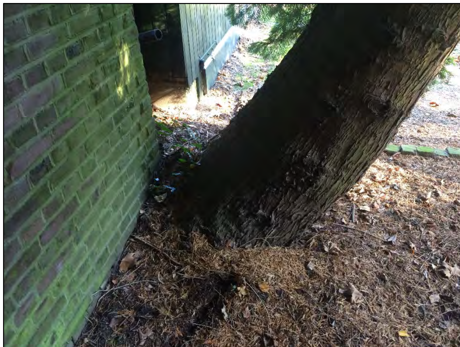
Figuur 9 Onhoudbare projectinvloed: boom 22 zal bij de sloop van het gebouw onherstelbaar beschadigd worden (beworteling).
