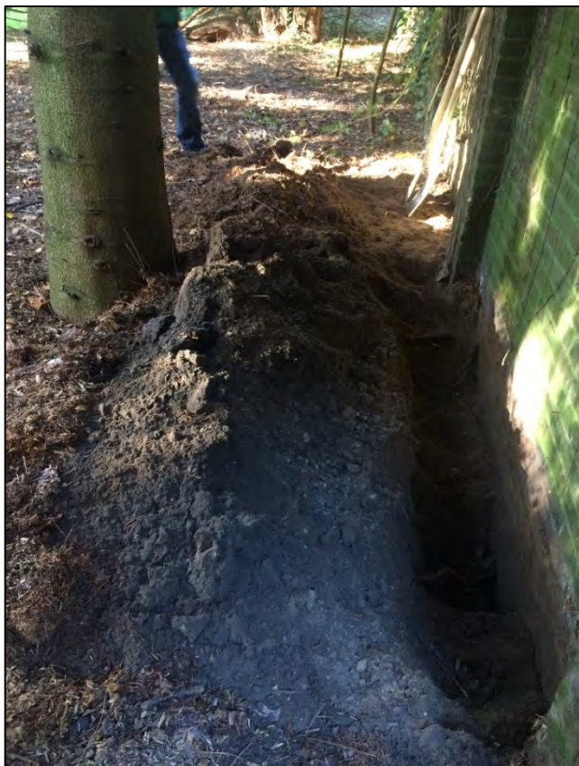
Figuur 10 Proefsleuf langs de te slopen muur ter hoogte van boom 25.
