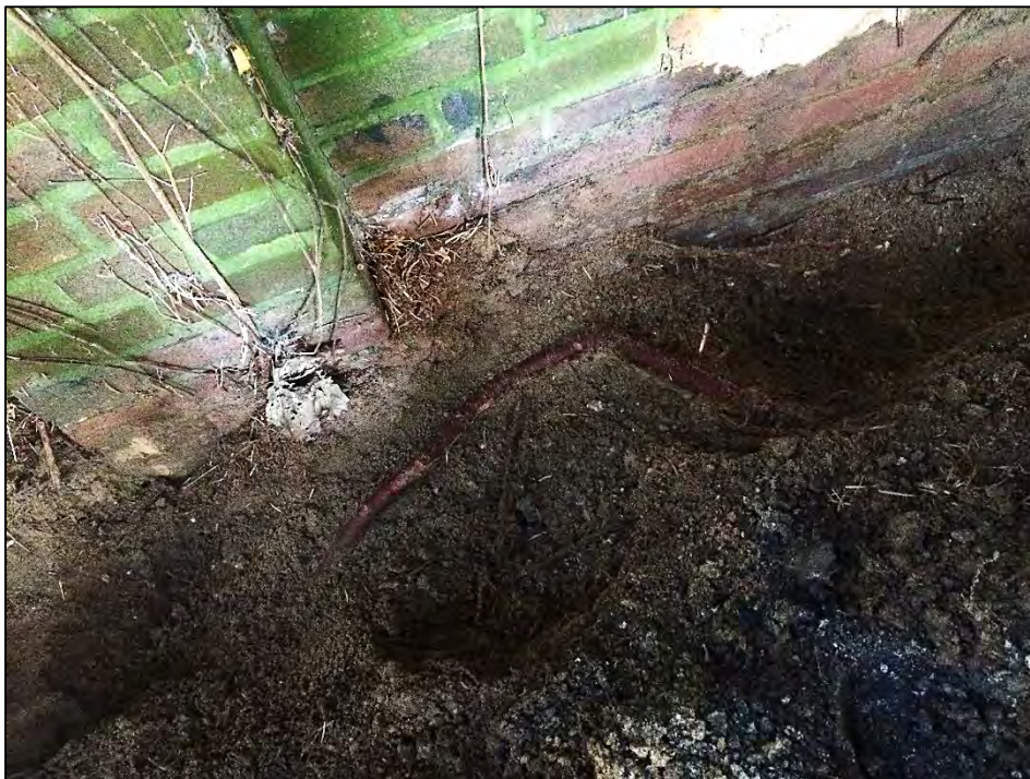
Figuur 11 Vrijgegraven wortel (Ø4 cm) langs te slopen muur, op 100 cm afstand van boom 25.
