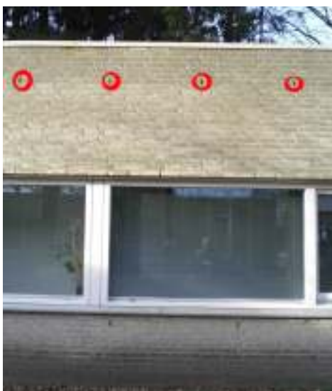
Gevels met open stootvoegen aan boszijde (Clabbers)
