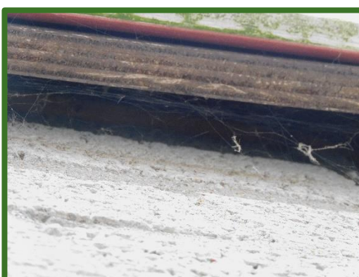
Houten betimmering dichtgemaakt met een panlat
