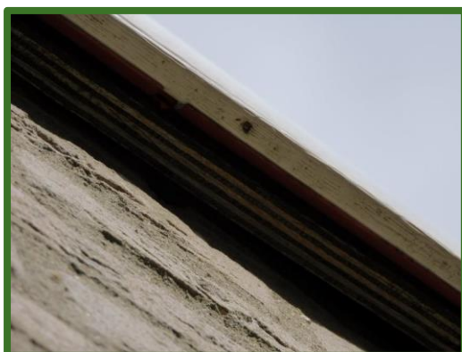
Houten betimmering dichtgemaakt met een panlat
