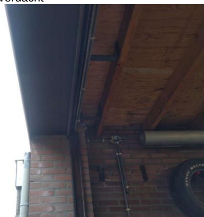
Boeiboord hout / pvc/ trespa niet verdacht
