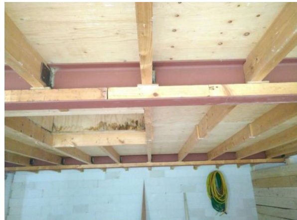
Constructie stelplaatjes hout niet verdacht
