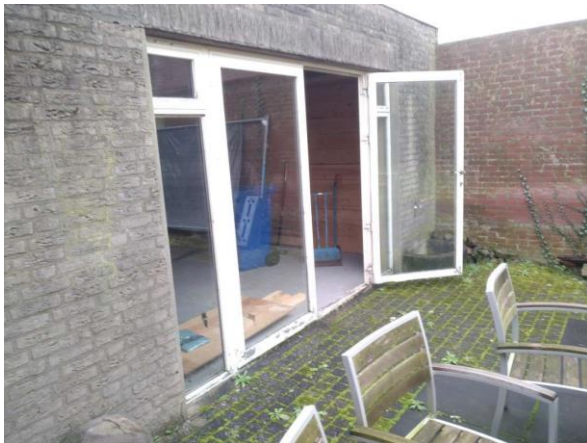
Kit aluminium kozijn niet verdacht
