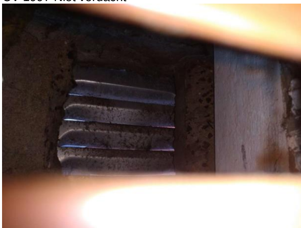
Ontluchting via spouw niet verdacht
