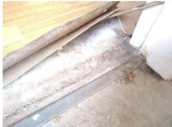
Ondervloer niet verdacht
