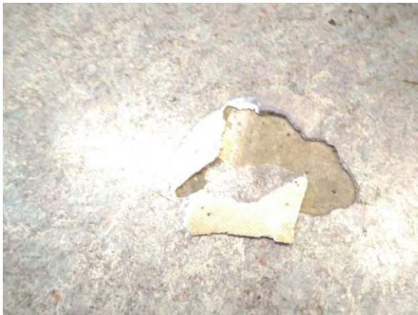
Ondervloer niet verdacht
