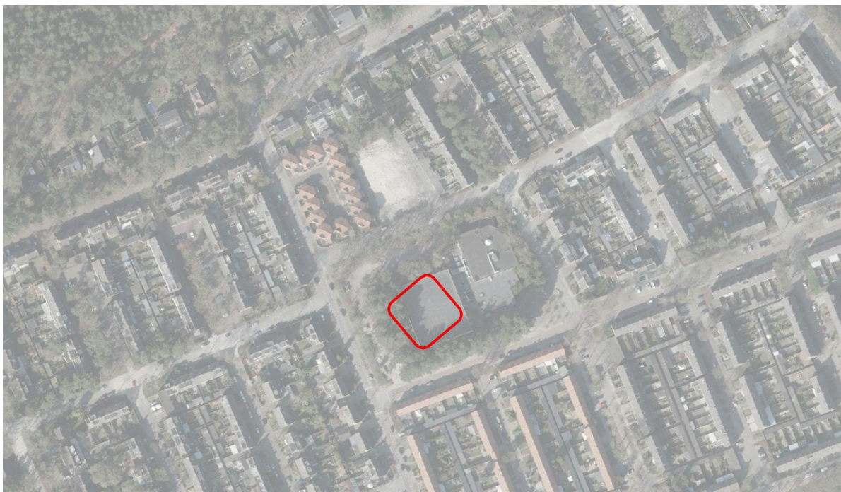
Figuur 3.1.1: Luchtfoto van het plangebied (rood omkaderd), voorafgaand aan de sloop van het gebouw.
