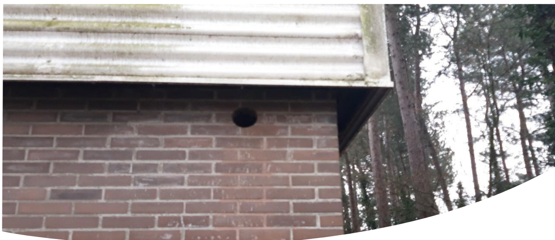
Afbeelding 3.6. Impressie aanwezige open gaten die toegang bieden tot de spouwmuur (deel 2).
