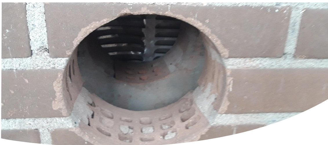
Afbeelding 3.5. Impressie aanwezige open gaten die toegang bieden tot de spouwmuur (deel 1).
