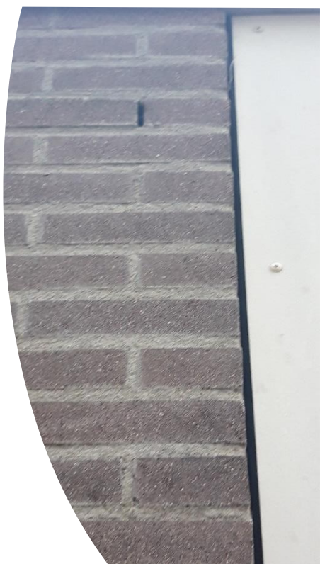
Afbeelding 3.9. Impressie aanwezige spleten en kieren bij kozijnen.
