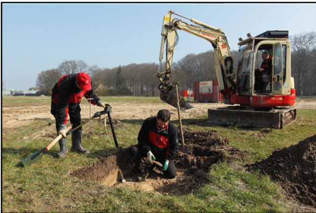
Figuur 6. Benaderen van een significant object m.b.v. een hydraulische graafmachine.
