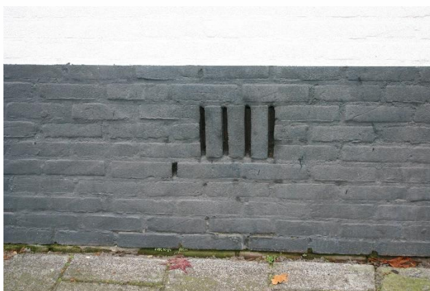
Figuur 4.4.4. Ventilatieopeningen en open stootvoegen bevinden zich op maximaal 40 cm hoogte.
