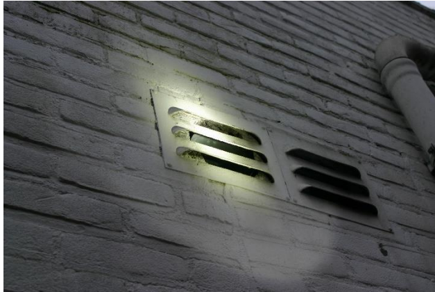
Figuur 4.4.2. De ventilatieopeningen zijn allemaal van metalen roosters voorzien.
