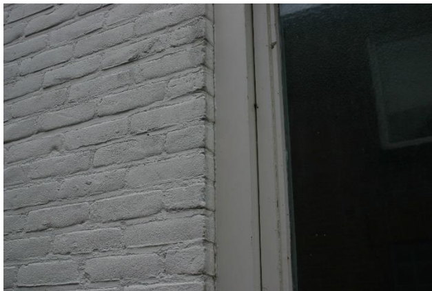
Figuur 4.4.3. Tussen de kozijnen en de gevel zitten geen kieren.
