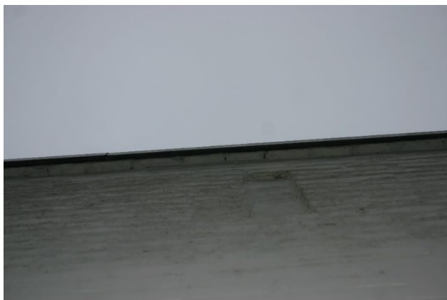
Figuur 4.4.1. De dakranden sluiten overal nauw aan op de gevel.
