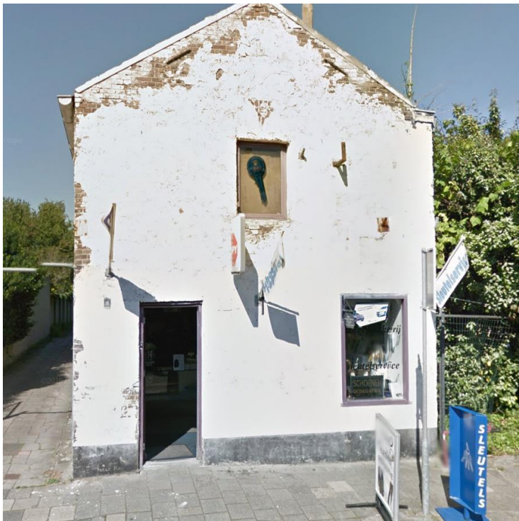
Figuur 3 Streetview situatie voor de sloop van het pand
