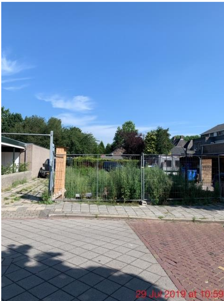
Figuur 5 Bestaande situatie na de sloop van het pand
