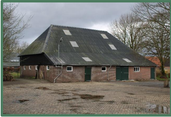
Foto 23: Schuur (8), vanaf het zuidoosten.
