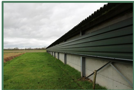
Foto 6: Oostelijke wand schuur 4, vanaf het noorden.
