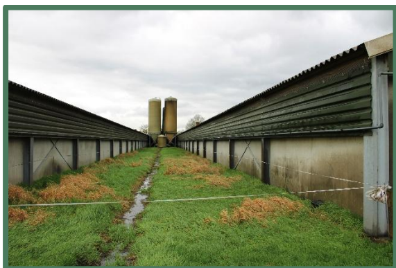
Foto 11: Schuur 2 en 3, vanaf het zuiden.
