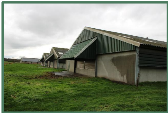
Foto 8: Schuur 4, 3 en 2, vanaf het oosten.
