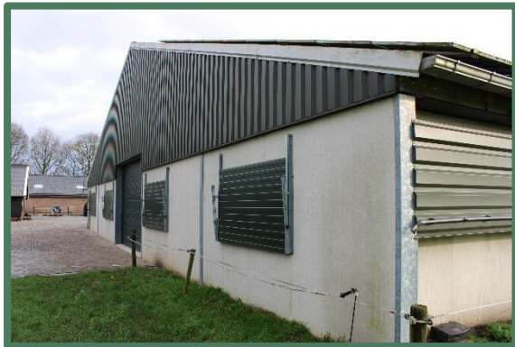
Foto 1: Noordelijke wand schuur 1, vanaf het westen.
