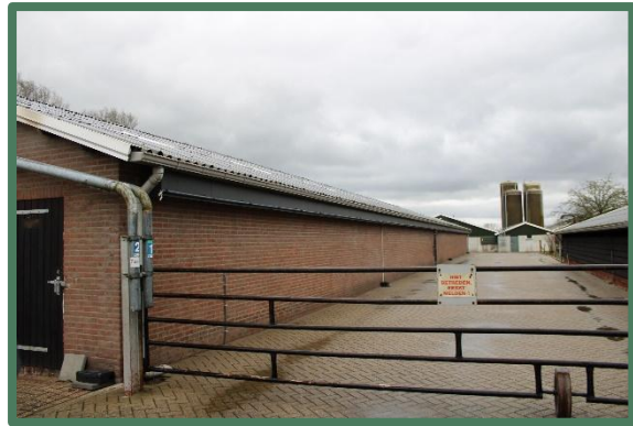
Foto 16: Westelijke wand schuur 1, vanaf het noordwesten.
