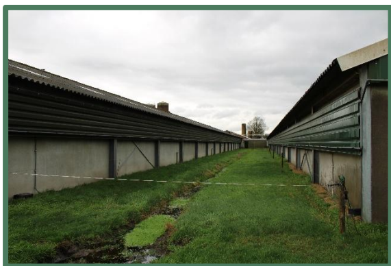
Foto 9: Schuur 3 en 4, vanaf het zuiden.
