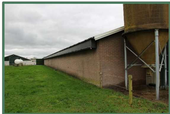
Foto 18: Oostelijke wand schuur 1, vanaf het noordoosten.
