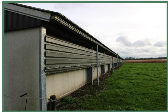
Foto 2: Westelijke wand schuur 1, vanaf het noordwesten.
