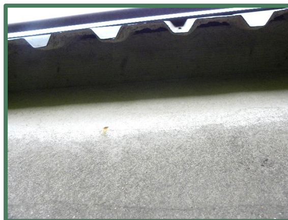
Foto 34: Damwand element voorzien van houten lat.
