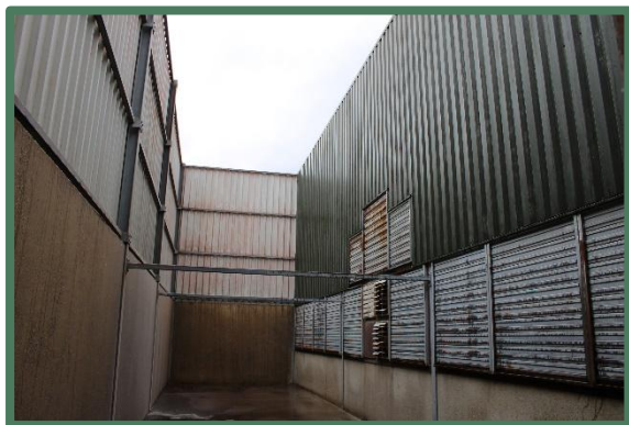
Foto 14: Binnenzijde ventilatiekamer ten zuiden van schuur 1.
