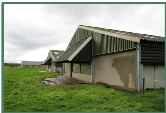
Foto 10: Schuur 3, vanaf het zuidoosten.
