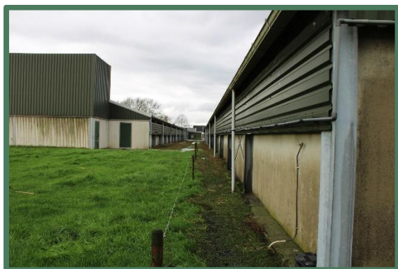
Foto 12: Schuur 1 en 2, vanaf het zuiden.
