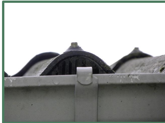
Foto 30: Dak voorzien van vogelschroot.
