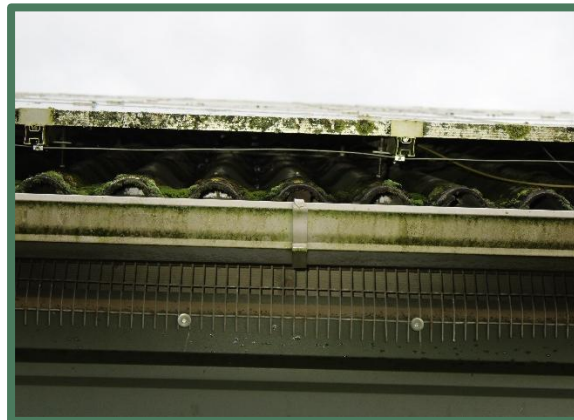
Foto 32: Dak voorzien van vogelschroot en vogelgaas.
