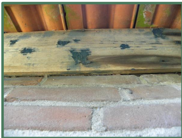
Foto 23: Noordoostelijke aanbouw gesloten met houten plaat.
