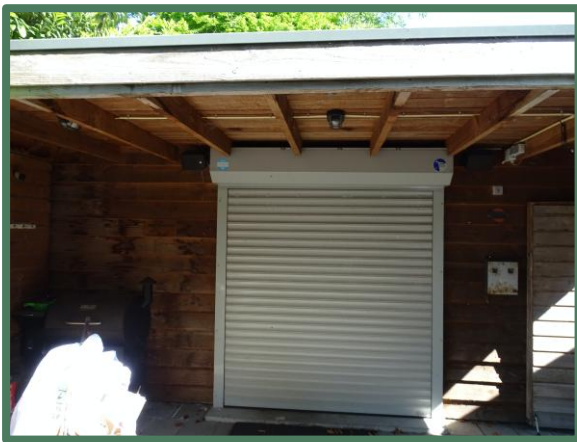
Foto 19: Bijgebouw met overkapping gelegen in het noordwesten.
