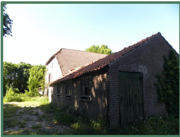
Foto 11: Overzicht bebouwing vanaf het noordoosten.
