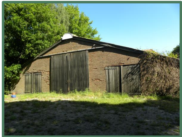
Foto 14: Zuidelijke kopgevel, voormalige ligboxenstal.
