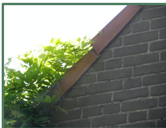
Foto 30: Kantpannen strak aangesloten op de gevel.
