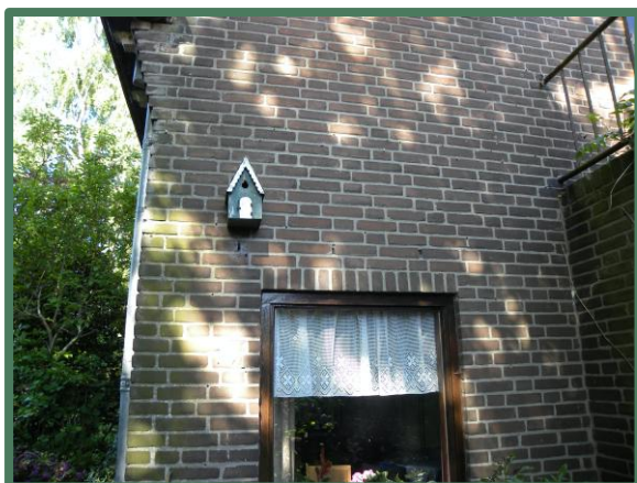
Foto 27: Woning, voorzien van enkele stootvoegen. Gesloten met spinnenwebben en slecht aanvliegbaar. Omringd door ruigte.
