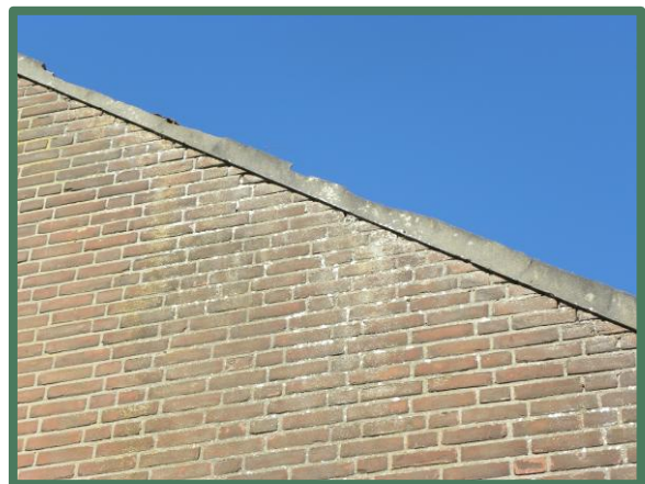
Foto 24: Oostelijke kopgevel van de schuur aangesmeerd met cement.
