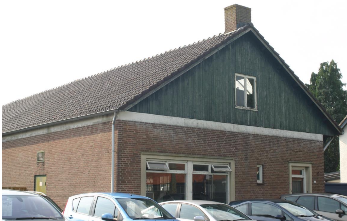
Figuur 4.1.3. De autostalling op nr. 30.
