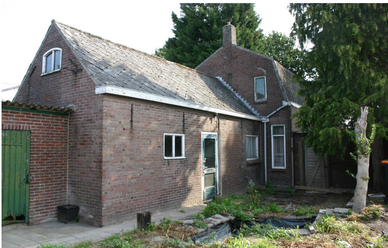
Figuur 4.5.1. Zijaanzicht van het woonhuis met bitumen dakbedekking. De achter aanbouw (links) heeft een golfplaten dak.
