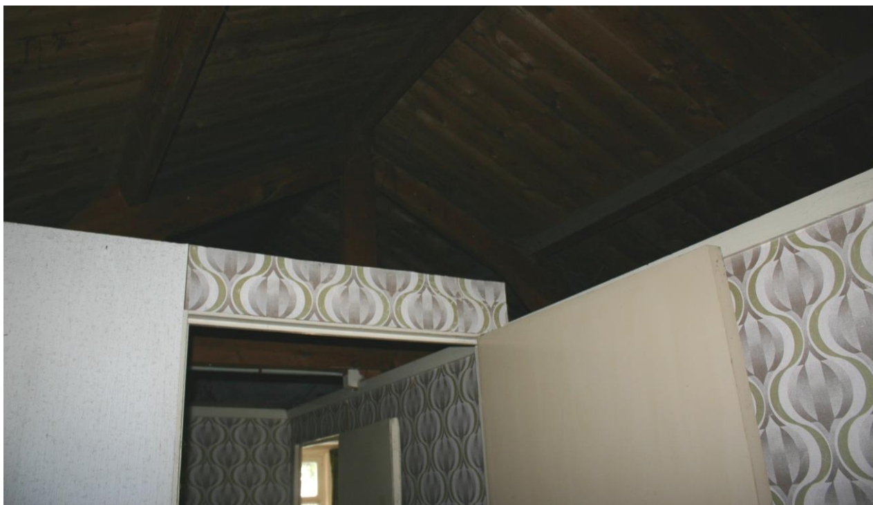
Figuur 4.5.3. De zolder van het woonhuis is niet door een vloer gescheiden van de bovenverdieping.
