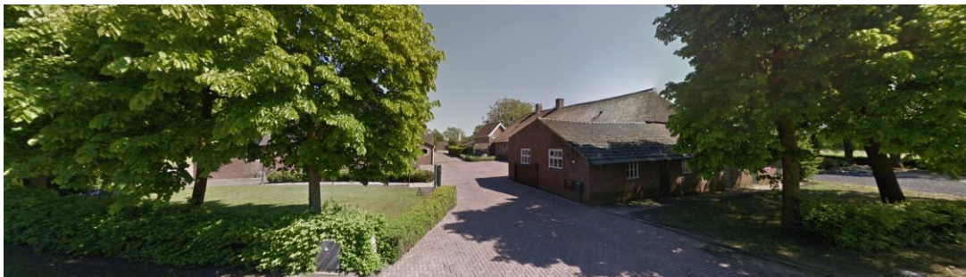
Aanzicht deellootatie Alphensebaan 72-74 (bedrijfswoning) vanaf Alphensebaan
