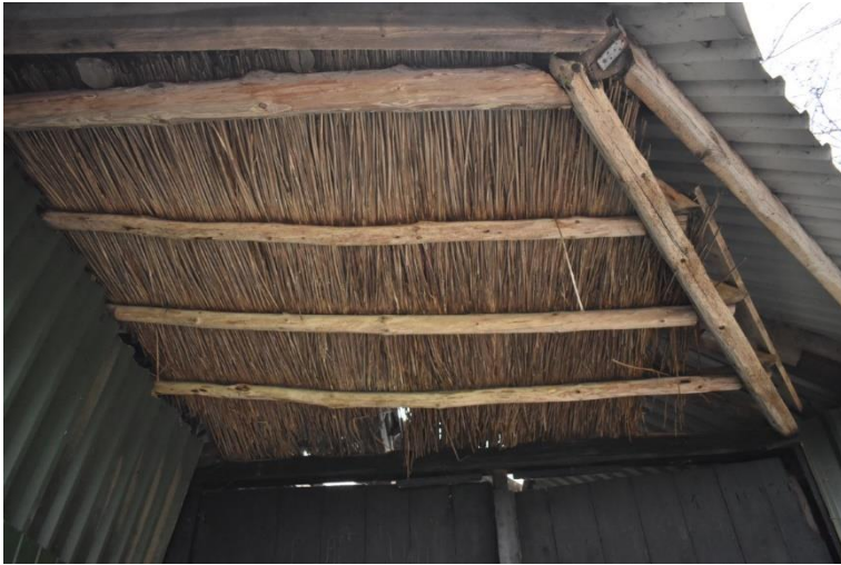
Rieten plafond in inham van de voorgevel.
