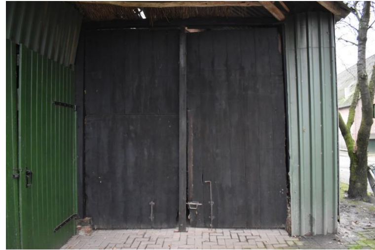
Oorspronkelijke deel deur in de voorgevel.
