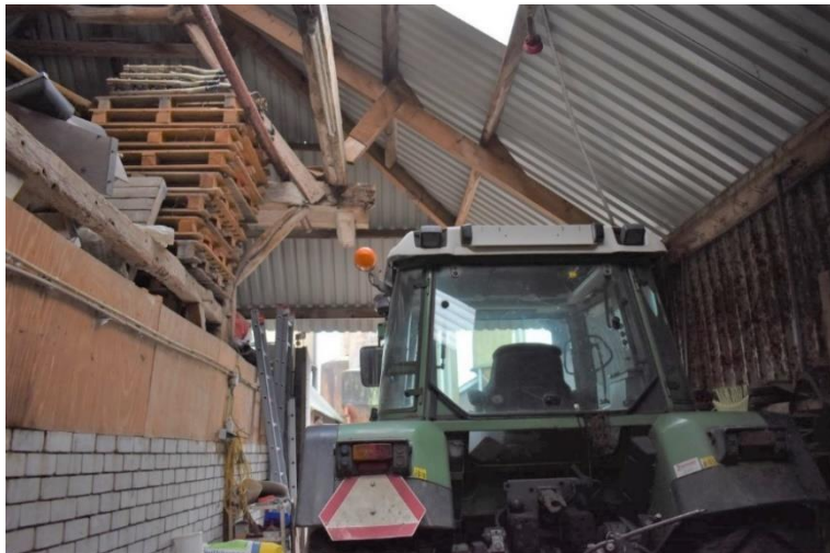
Zijlansdeel gezien richting de achtergevel.
