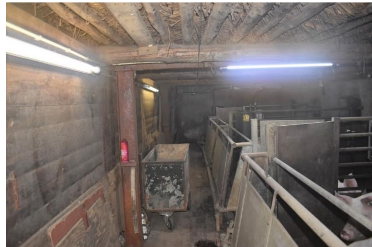
Gedeelte van de schuur dat in gebruik is als varkensstal.
