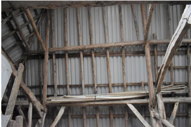
Rondhouten spanten, gordingen en sporen.
