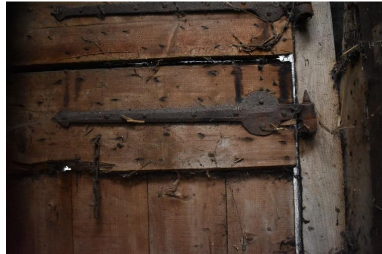
Oorspronkelijk smeedijzeren geheng aan de deel deur.
