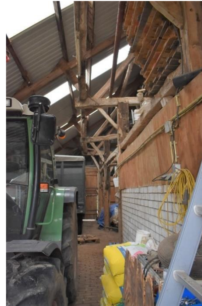
Zijlansdeel richting voorgevel.
