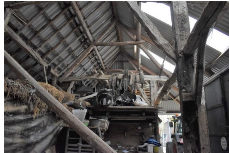
Ankerbalk-dekbalkgebint met daarop een A-spant.
