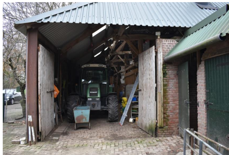
Vernieuwde deel deur aan linkerzijde van de achtergevel.
