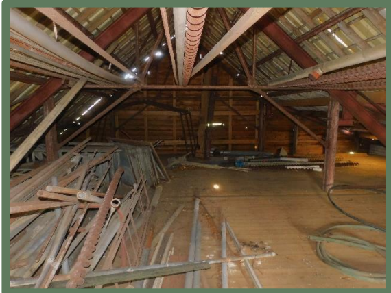
Overzicht op zolder
