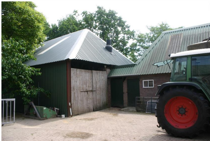
Figuur 4.1.19. Gebouw 1 (in figuur 4.1.18) heeft een golfstalen dak.
