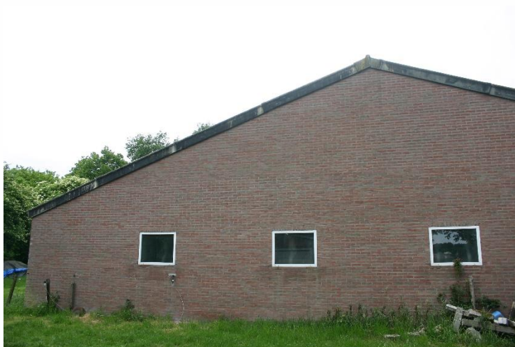
Figuur 4.1.22. Gebouw 4 (in figuur 4.1.18) heeft een dak van cement houdende golfplaten.
