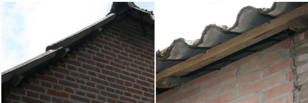
Figuur 4.4.11. De daken en gevels van gebouw 2 (in figuur 4.1.18) zijn volledig enkelwandig en ook in het gebouw waren vogelnesten, uitwerpselen etc. afwezig.
