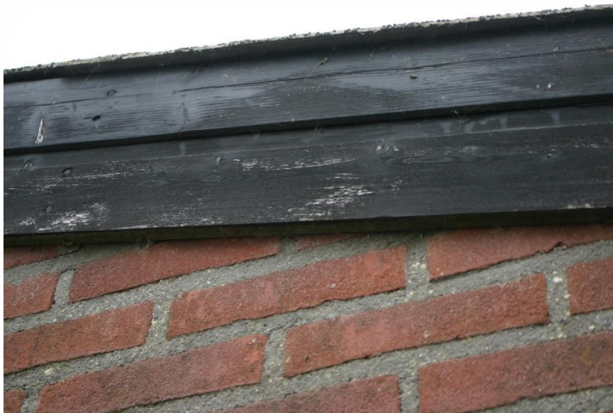
Figuur 4.4.4. Bij de kopgevels van de te slopen gebouwen in deelgebied 2 is er geen kier die vleermuizen of vogels toegang kan geven tot de spouw.
