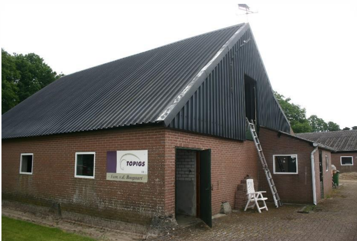
Figuur 4.1.12. Gebouw 4 (in figuur 4.1.11) heeft een golfstalen dak.
