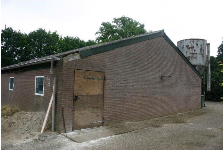
Figuur 4.1.13. Gebouw 5 (in figuur 4.1.11) is een varkensstal met een cementshoudend golfplaten dak.
