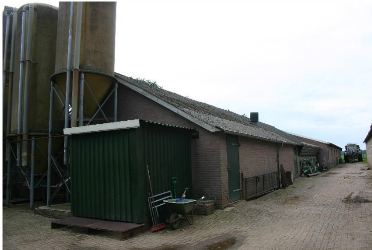
Figuur 4.1.21. Gebouw 3 (in figuur 4.1.18) heeft een dak van cement houdende golfplaten.
