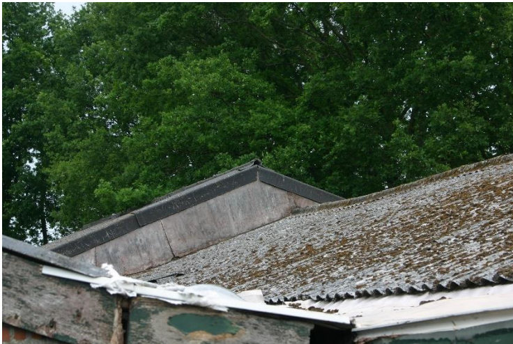
Figuur 4.1.14. De daken op gebouw 8 (in figuur 4.1.11).
