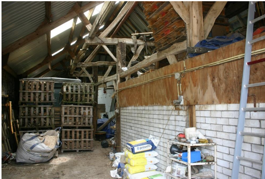
Figuur 4.4.10. De daken en gevels van gebouw 1 (in figuur 4.1.18) zijn volledig enkelwandig en ook in het gebouw waren vogelnesten, uitwerpselen etc. afwezig.
