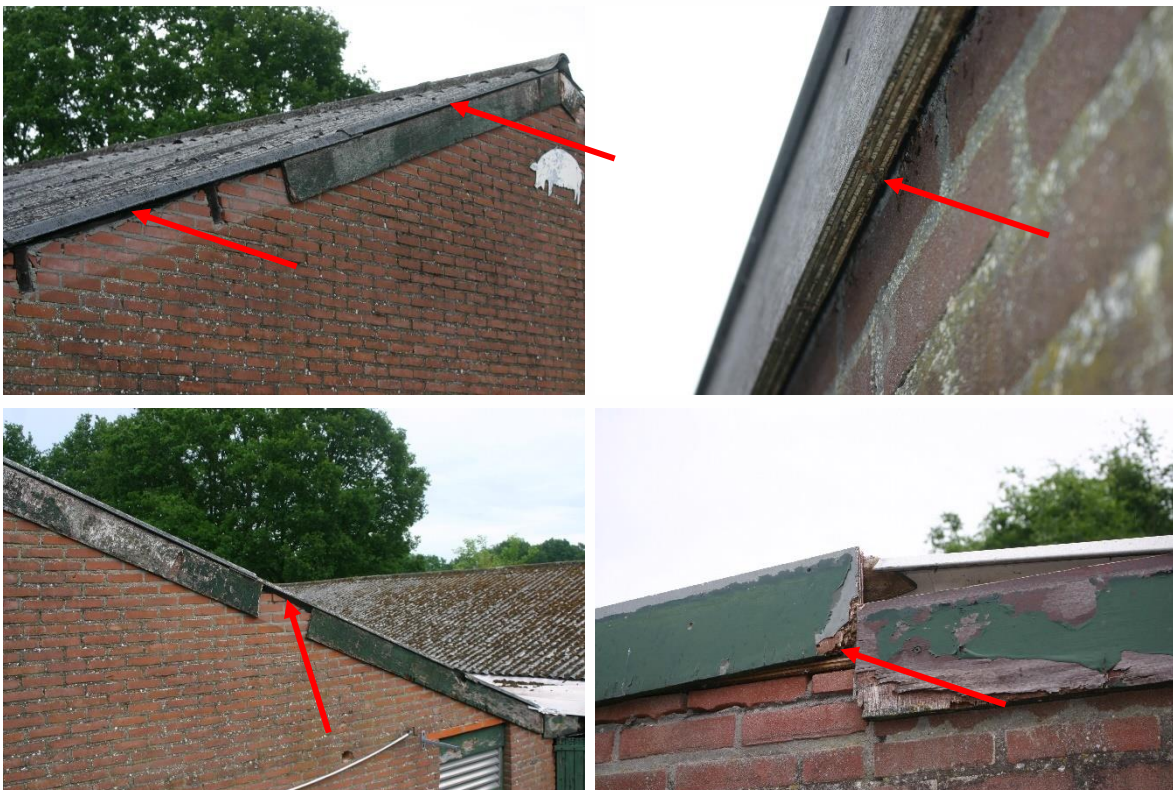
Figuur 4.4.9. De meeste bedrijfsgebouwen in het plangebied hebben vele kieren (rode pijlen) waar vleermuizen door naar binnen kunnen.
