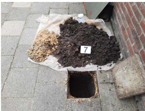
Asbestinspectiegat 7
