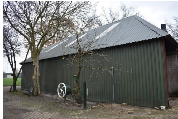
Vernieuwde rechterzijgevel in damwand.
