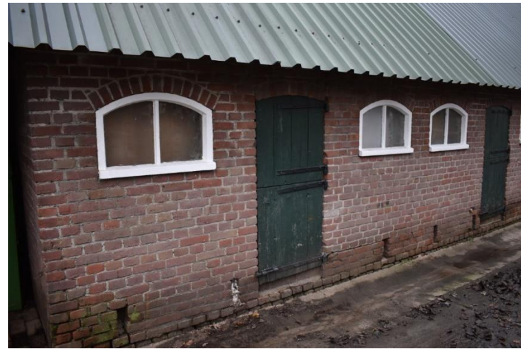
Metselwerk uit 2 e kwart 20 ste eeuw in linkerzijgevel schuur.
