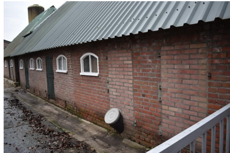
Rechtergedeelte linkerzijgevel schuur metselwerk uit 1960.
