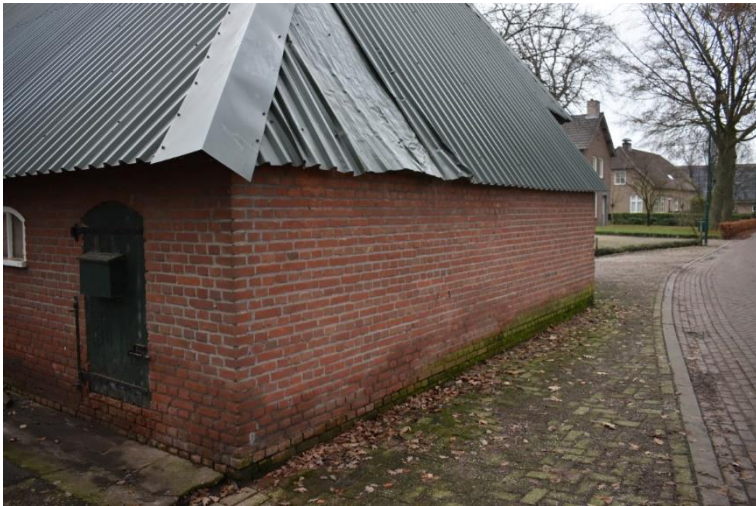
Metselwerk uit 1960 in de voorgevel.
