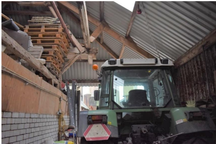
Zijlansdeel gezien richting de achtergevel.
