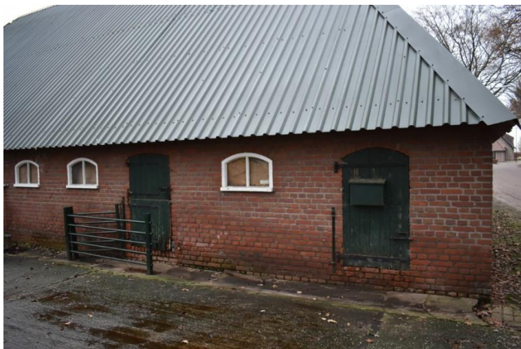
Rechtergedeelte linkerzijgevel schuur metselwerk uit 1960.
