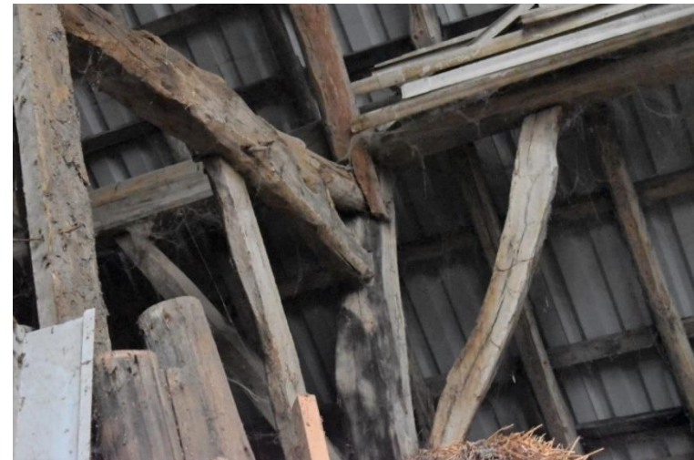
Gevorkte ankerbalk in een van de gebinten.
