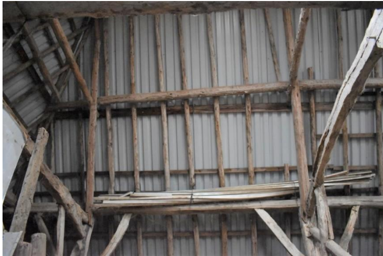
Rondhouten spanten, gordingen en sporen.
