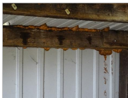
Foto 25: Te slopen bedrijfsgebouw (staalplaten deels gedicht met PUR).
