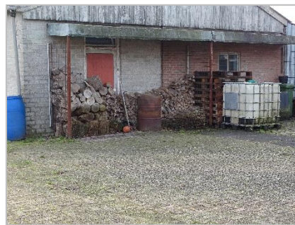
Foto 4: Impressie te slopen bedrijfsgebouw (gevel noordzijde).
