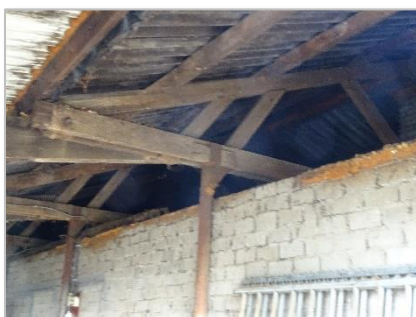
Foto 24: Te slopen bedrijfsgebouw (open deel naar zolderruimte).
