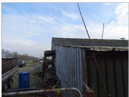
Foto 11: Impressie te slopen bedrijfsgebouw (dak van asbest golfplaten en staalplaten).
