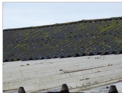
Foto 10: Impressie te slopen bedrijfsgebouw (dak van asbest golfplaten en staalplaten).
