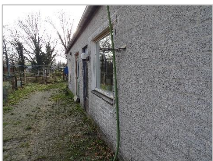
Foto 5: Impressie te slopen bedrijfsgebouw (gevel oostzijde).
