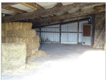
Foto 23: Te slopen bedrijfsgebouw (open deel naar stro-opslag).
