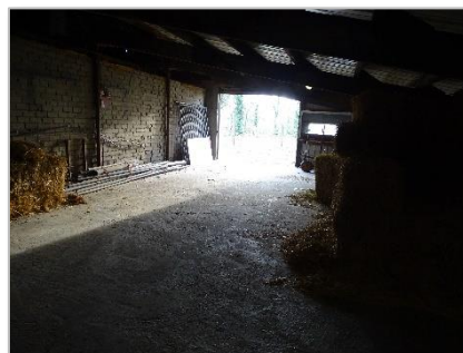
Foto 22: Te slopen bedrijfsgebouw (open deel naar stro-opslag).
