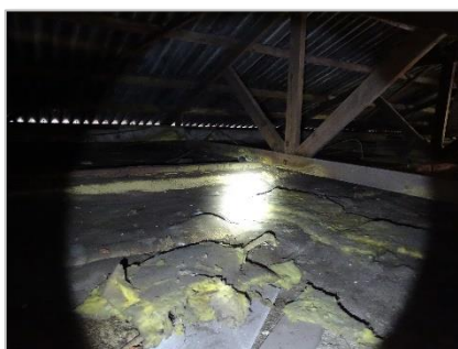
Foto 18: Te slopen bedrijfsgebouw (zolderruimte).
