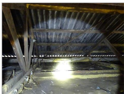
Foto 14: Te slopen bedrijfsgebouw (zolderruimte met openingen bij dak).
