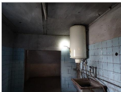
Foto 21: Te slopen bedrijfsgebouw (voormalige wasruimte).
