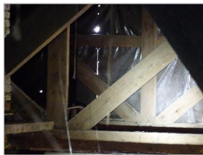
Foto 16: Te slopen bedrijfsgebouw (zolderruimte).
