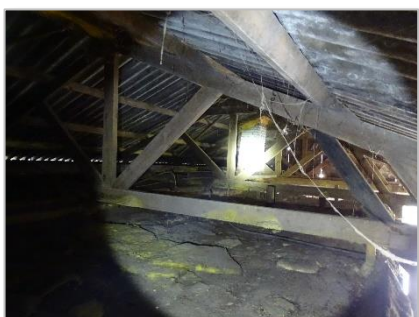
Foto 17: Te slopen bedrijfsgebouw (zolderruimte).
