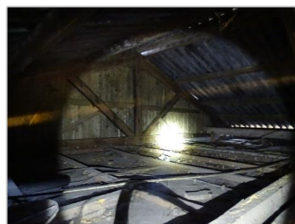
Foto 19: Te slopen bedrijfsgebouw (zolderruimte).
