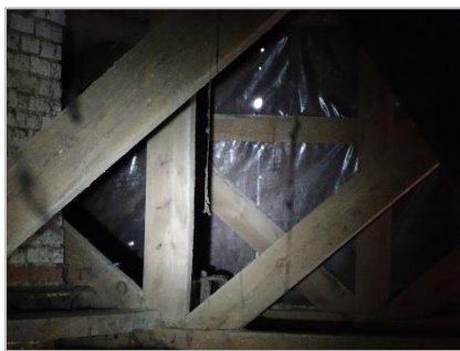
Foto 15: Te slopen bedrijfsgebouw (zolderruimte).
