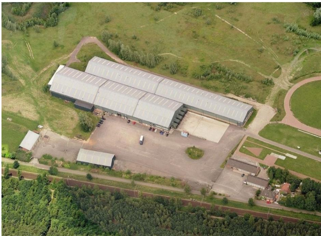
Figuur 3: luchtfoto bestaande situatie
