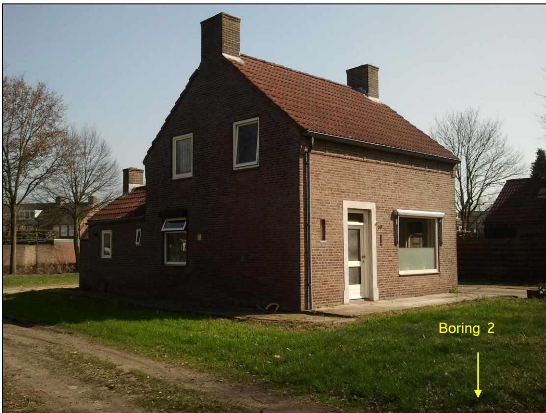
Figuur 2: plangebied bij aanvang van de werkzaamheden.
