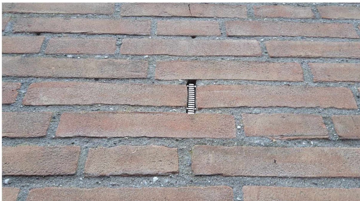
Afbeelding 4.2. Open stootvoegen zijn niet toegankelijk voor vleermuizen door de aanwezigheid van ijzeren strips in de stootvoegen.
