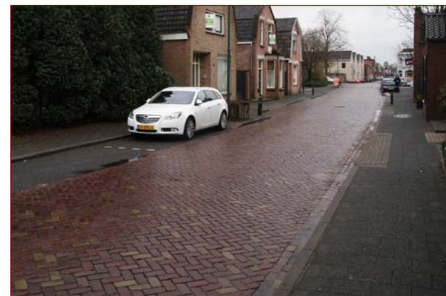
De bestaande inrichting van de Lange Wagenstraat
