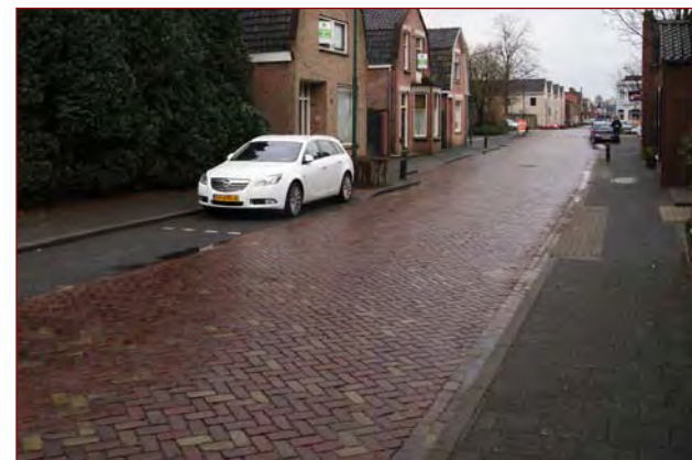
De bestaande inrichting van de Lange Wagenstraat
