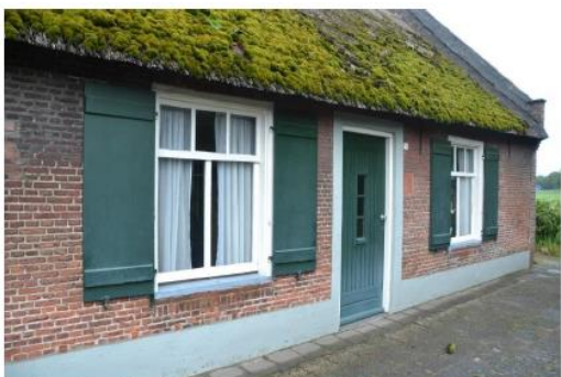
Linkerzijgevel ter hoogte van oorspronkelijk woongedeelte.
