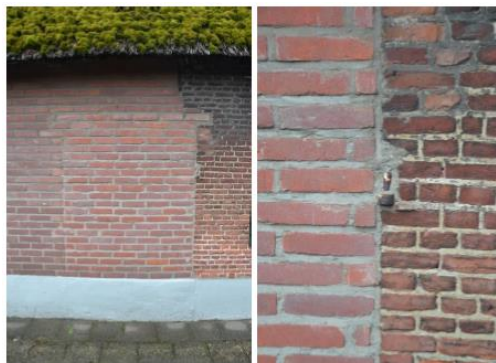
Dichtgemetselde deuropening (L) en detail van resterende duim (R).
