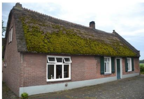
Linkerzijgevel naar het noorden gezien.
