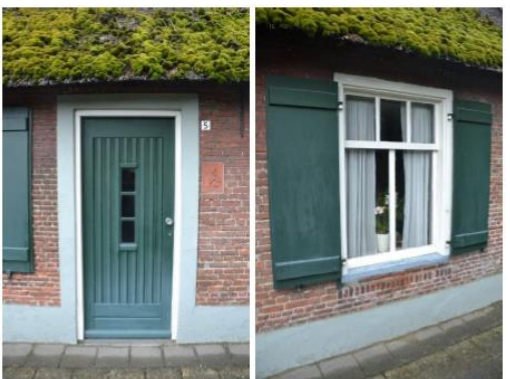
Voordeur in linkerzijgevel (L) en één van de schuifvensters (R).
