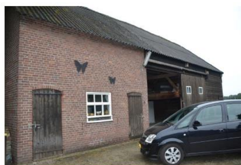
Linkerzijgevel naar het noorden gezien.
