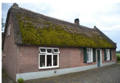
Linkerzijgevel naar het noorden gezien.
