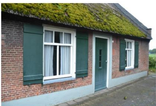
Linkerzijgevel ter hoogte van oorspronkelijk woongedeelte.
