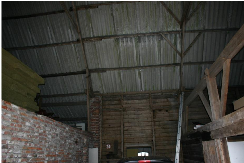
Figuur 4.4.1. Het dak en de wanden van de tot woonhuis om te vormen schuur zijn vrijwel geheel enkelwandig.
