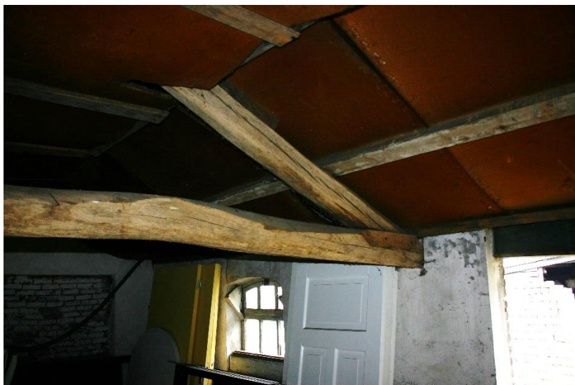
Figuur 4.4.2. De ruimte boven deze plafondplaten werd tijdens het veldbezoek volledig met een boomcamera geïnspecteerd.
