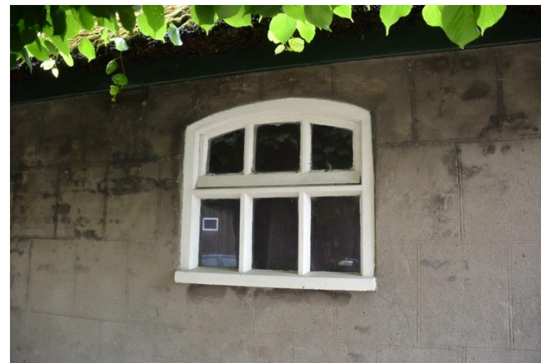
Betonnen stalraam in vm. stalgedeelte.
