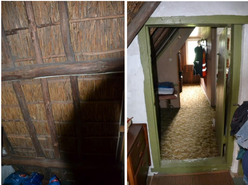
Detail gordingen en sporen (L) en deur in de brandmuur (R).
