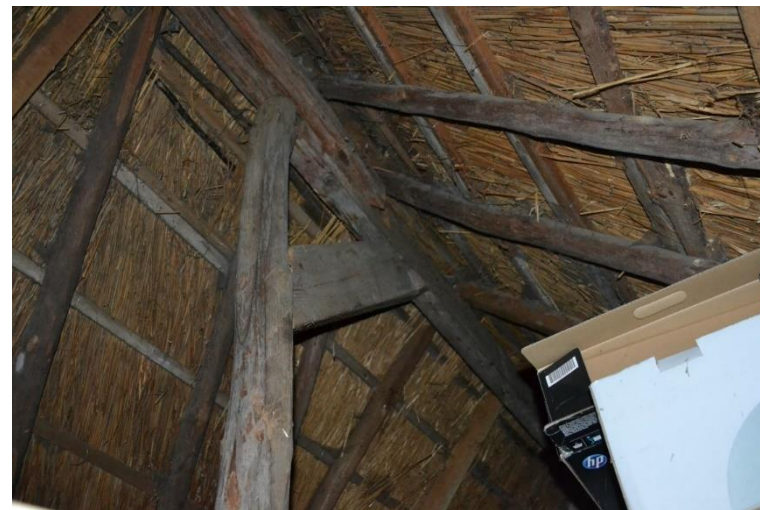
Verlengde kap t.h.v. voormalig wolfseind.
