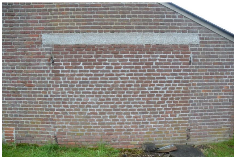
Dichtgezette deuropening.
