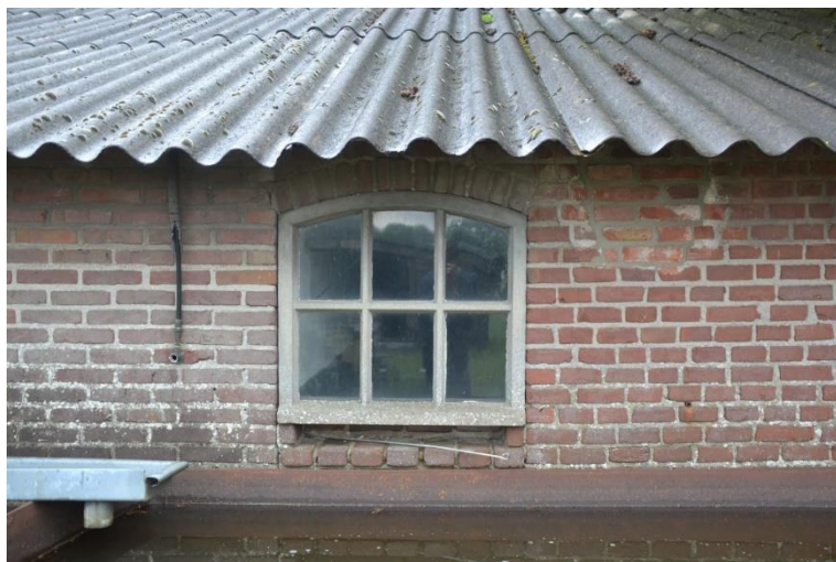
Links van het venster het oudere metselwerk, rechts het nieuwere metselwerk van de stalvergroting.
