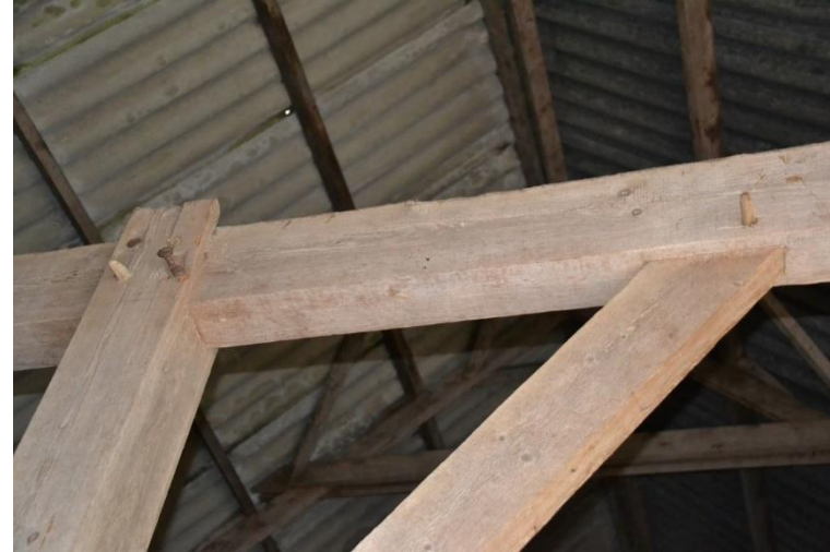
Detail verbindingen gebintconstructie.
