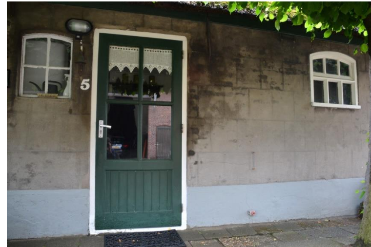
Vm. stalgedeelte rechterzijgevel.
