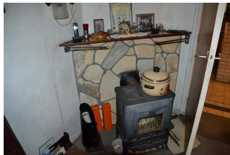
Een van de schouwen met Solnhofer flagstone bekleed in de voorkamer.
