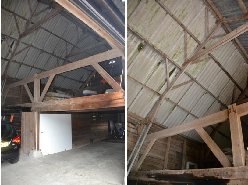
Gebint- en spantconstructie.
