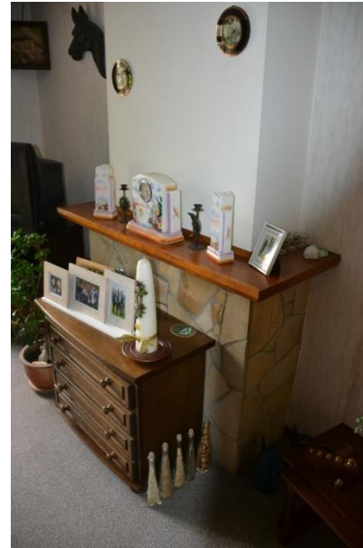
Schouw bekleed met Solnhofer flagstone in achterkamer.
