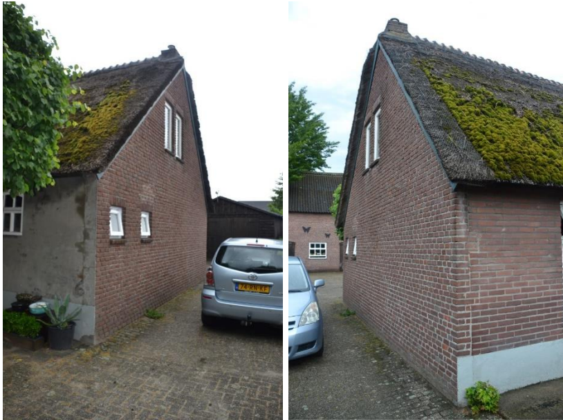
De achtergevel naar het oosten gezien (L) en naar het westen gezien (R).
