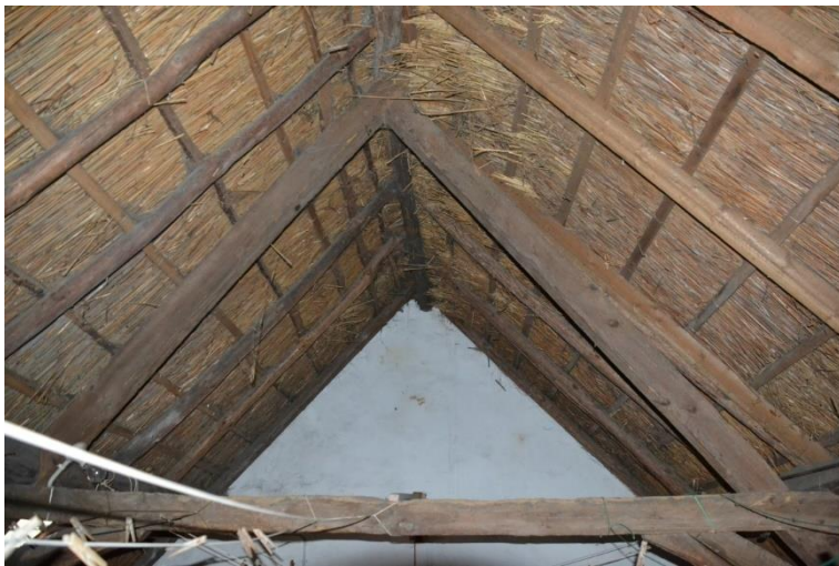
Links ronde daksporen, rechts vernieuwde daksporen.
