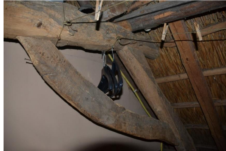
Detail spant met schoor.
