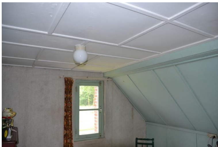
Slaapkamer op de verdieping aan de voorzijde.
