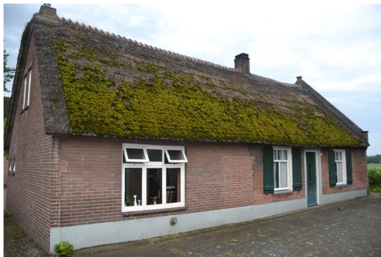
Linkerzijgevel naar het noorden gezien.
