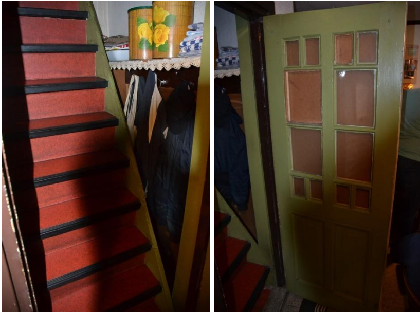
Huidige trapopgang in vm. kast (L) en toegangsdeur tot trapopgang (R).
