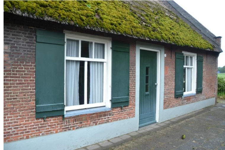
Linkerzijgevel ter hoogte van oorspronkelijk woongedeelte.
