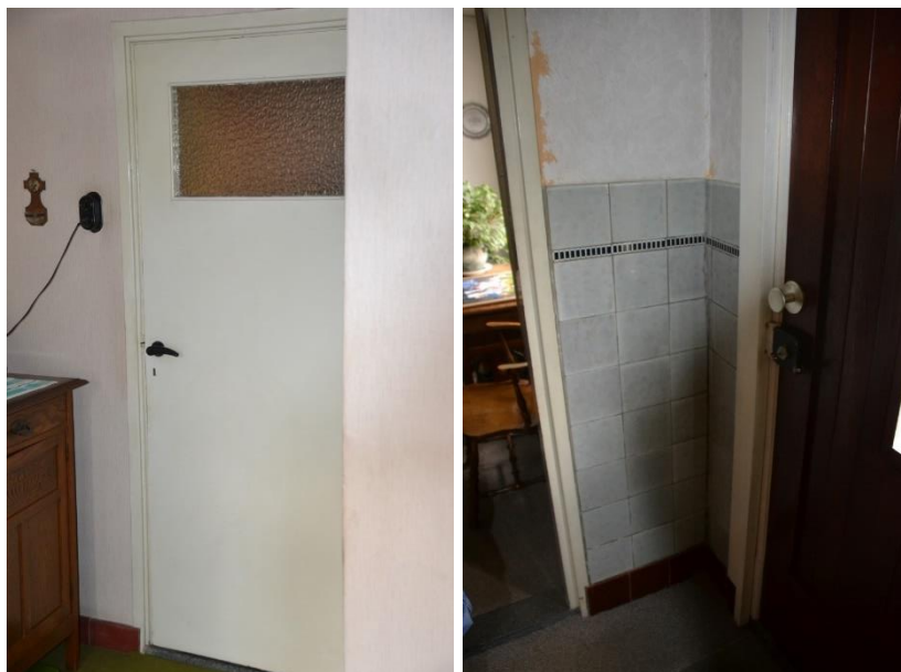
Deur tussen slaapkamer en vm. voorstal (L) en tegellambrisering in de kleine hal achter de voordeur (R).
