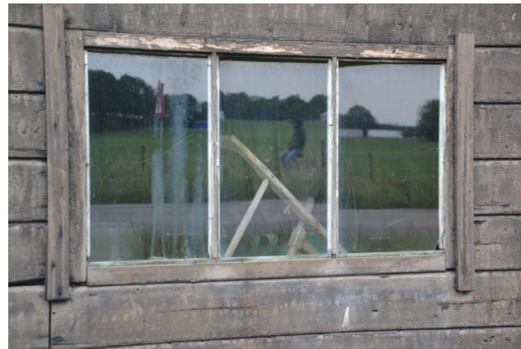
Detail venster in voorgevel.
