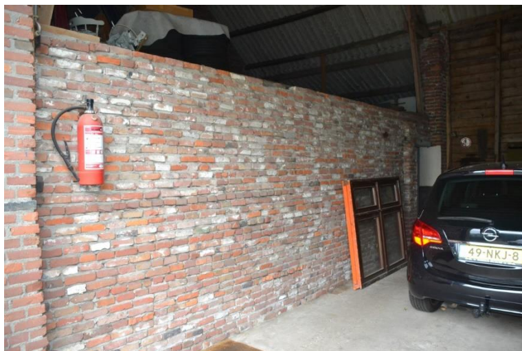
Binnenmuur t.h.v. voormalige achtergevel schuur.
