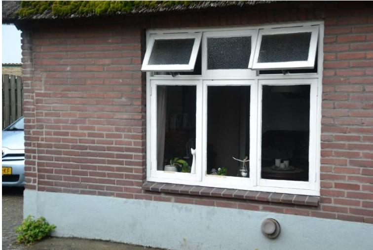
Venster links in de linkerzijgevel.
