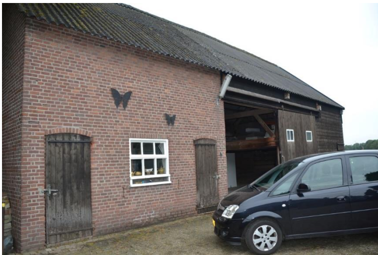
Linkerzijgevel naar het noorden gezien.
